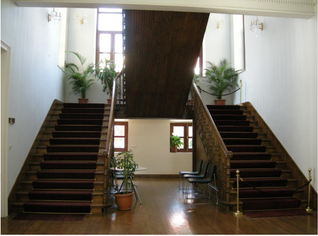
Resim 98: Süleymanpaşa Belediye Binası, restorasyon sonrası zemin kat merdivenlerinin görünümü.
