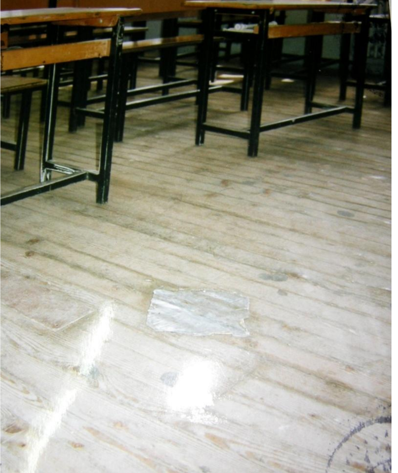
Resim 68: Süleymanpaşa Anaokulu, restorasyon öncesi ahşap zemini (E.K.V.K.B.K Arşivi).
