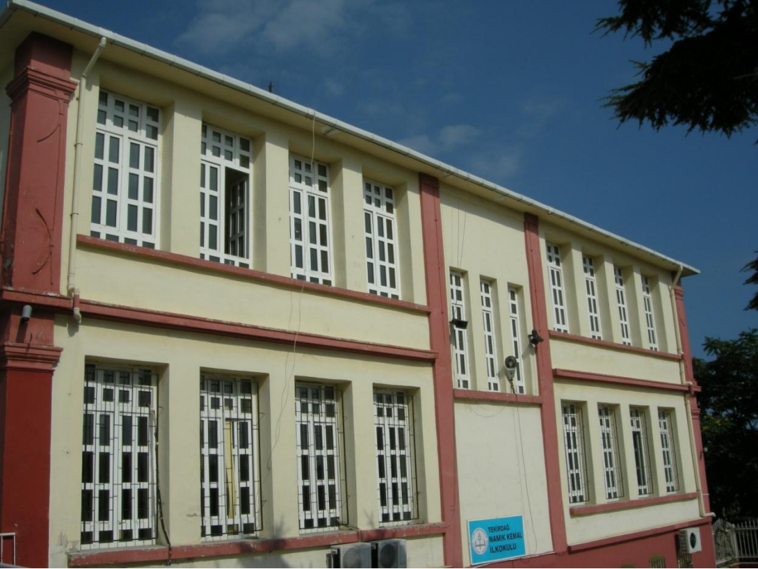
Resim 48: Namık Kemal İlkokulu 2. Kısım, batı cephe.
