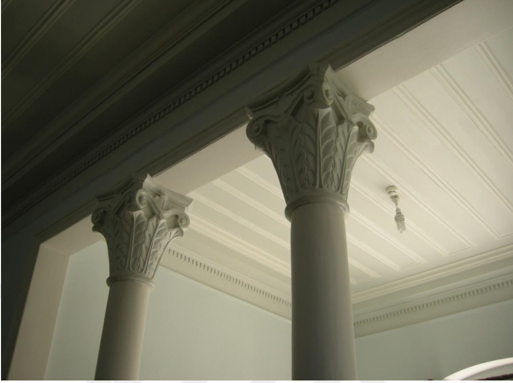
Resim 96: Süleymanpaşa Belediye Binası, zemin kat sütunlarının restorasyon sonrası görünümü.
