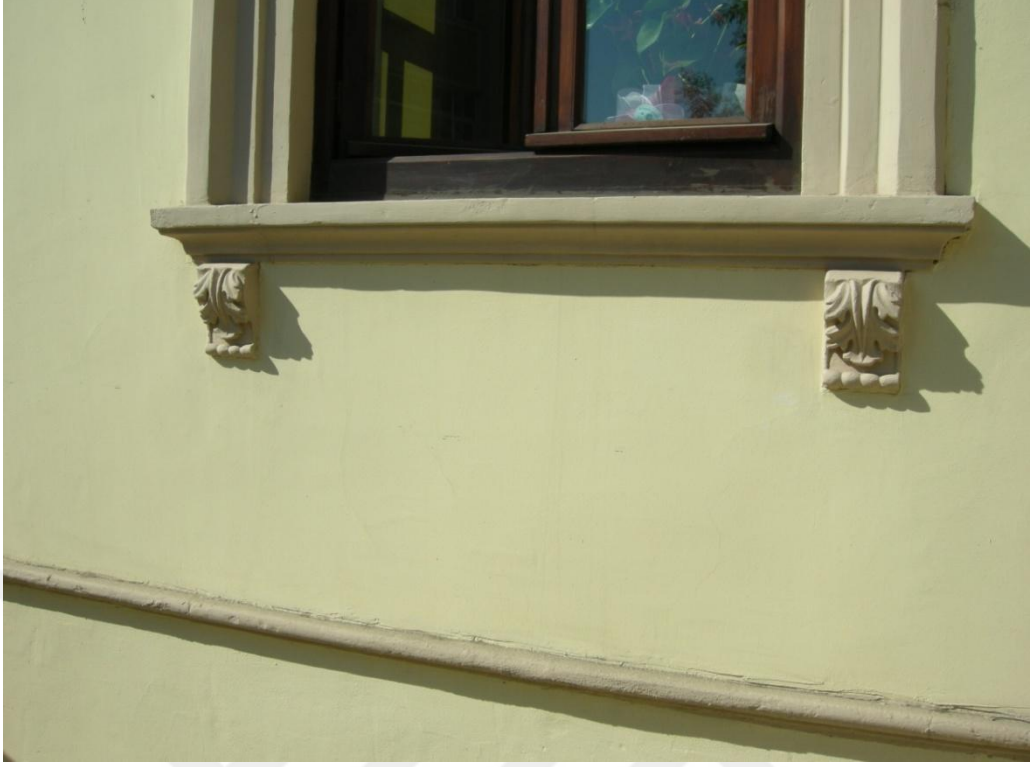
Resim 114: Süleymanpaşa Belediye Binası, güney cephe pencere detayı.
