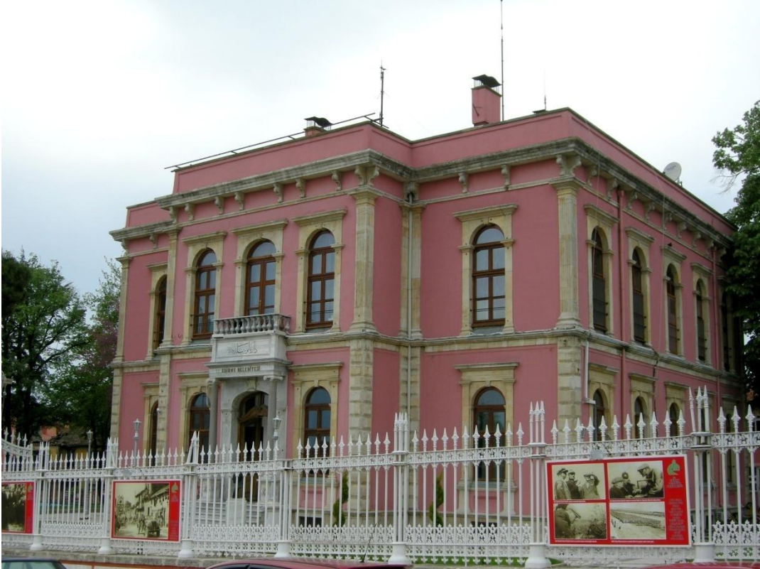
Resim 165: Edirne Belediye Binası, güneydoğudan görünüş.
