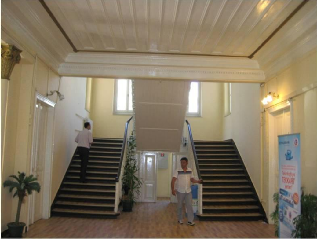
Resim 97: Süleymanpaşa Belediye Binası, restorasyon öncesi zemin kat merdivenlerinin görünümü (Çağatay Çavuşoğlu).
