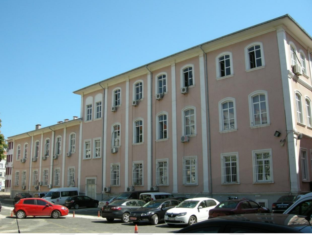
Resim 124: Valilik Binası, kuzey cephe.
