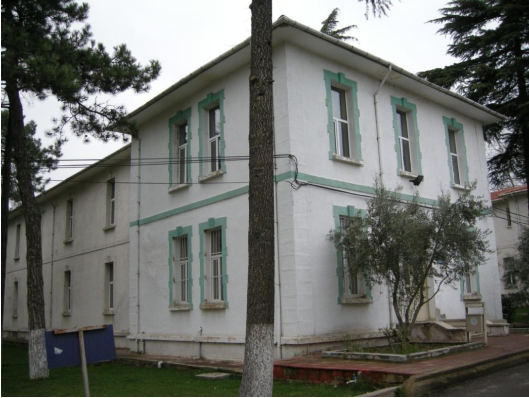
Resim 155: Araştırma ve Uygulama Hastanesi, güneybatı binası güney cephenin güneybatıdan görünümü.
