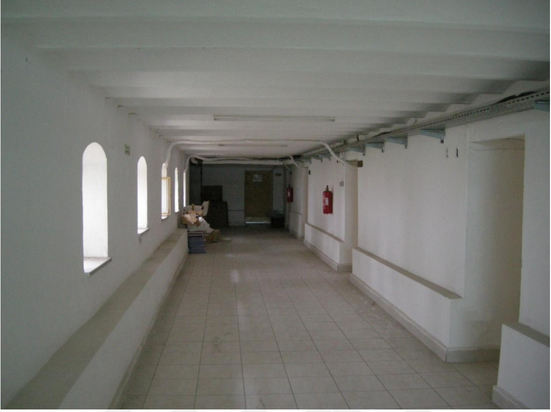
Resim 134: Valilik Binası, bodrum kat güney koridoru.
