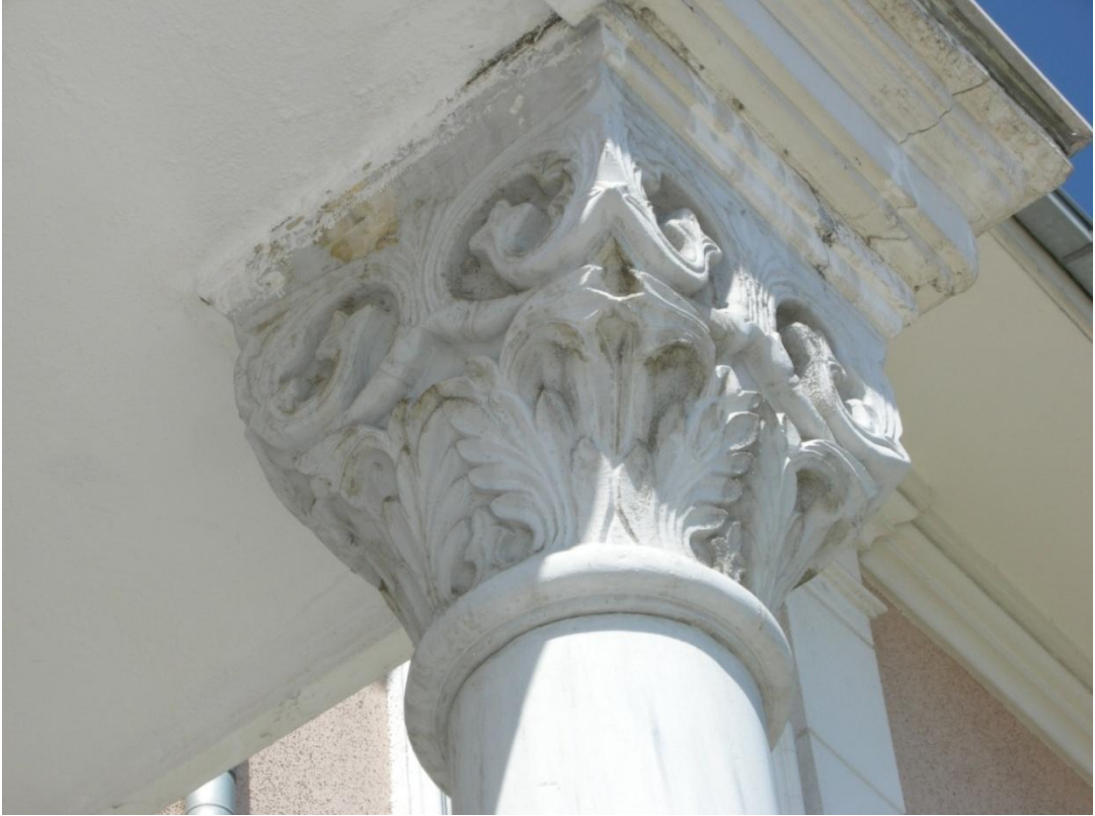
Resim 137: Valilik Binası, giriş bölümü sütun detayı.
