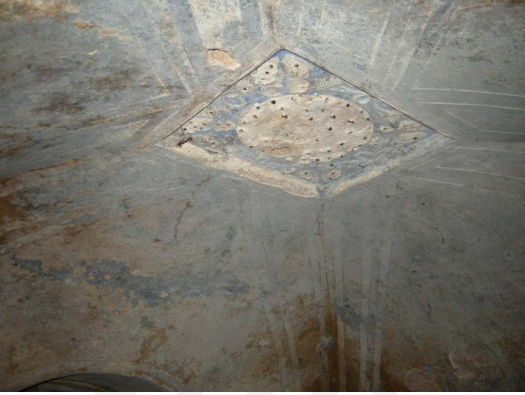
Resim 43: Güzel Sanatlar ve Spor Lisesi, 2. bodrum kat mekanı tavan detayı.
