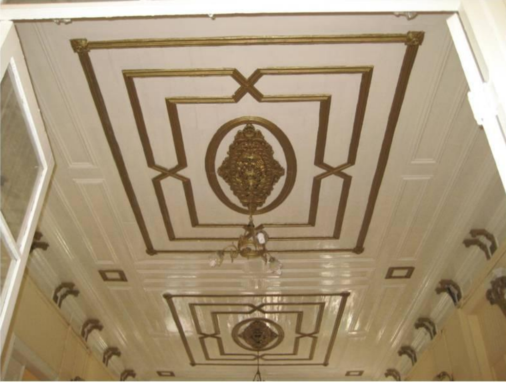
Resim 103: Süleymanpaşa Belediye Binası, restorasyon öncesi 1. kat hol tavanının görünümü (Çağatay Çavuşoğlu).
