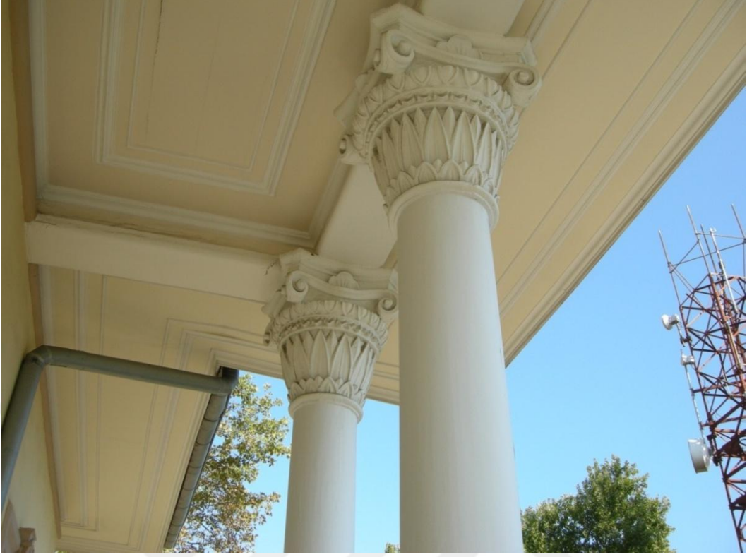
Resim 112: Süleymanpaşa Belediye Binası, güney cephe 1. kat balkon sütunları.
