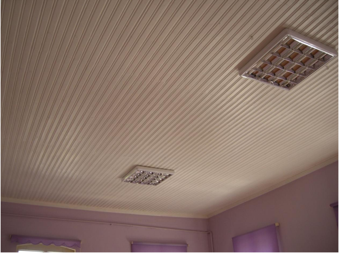
Resim 70: Süleymanpaşa Anaokulu, güneybatı dersliđi tavanı.
