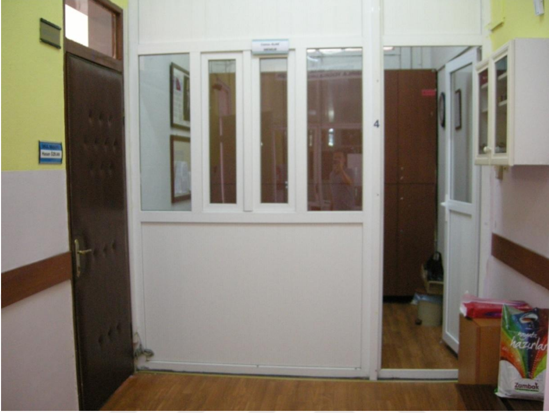
Resim 54: Namık Kemal İlkokulu 2. Kısım, zemin kat koridoru kuzey kısmına eklenen mekan.
