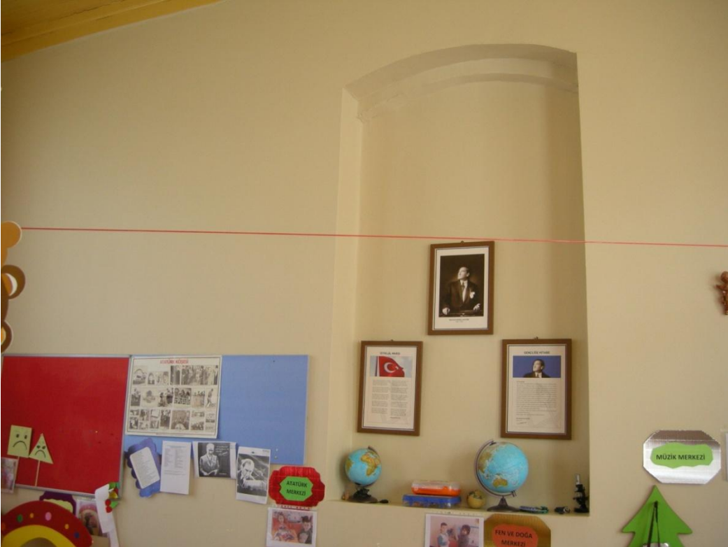
Resim 22: Yahya Kemal Beyatlı Anaokulu, 1. kat doğu cephede kapatılan pencere.
