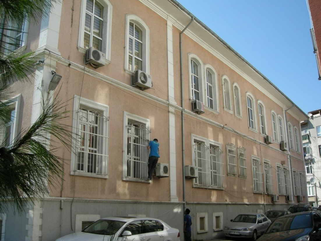
Resim 125: Valilik Binası, doğu cephe.
