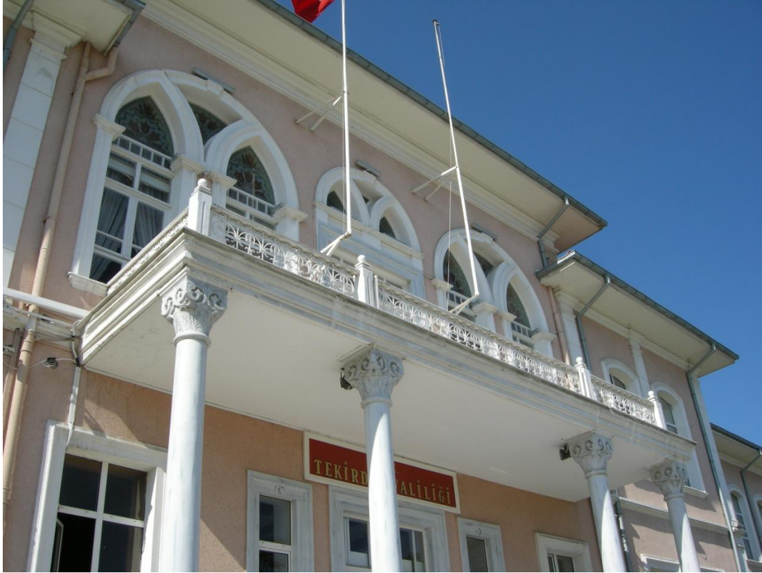
Resim 123: Valilik Binası, güney cephe ana giriş.
