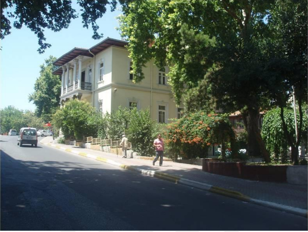
Resim 94: Süleymanpaşa Belediye Binası, restorasyon öncesi (Çağatay Çavuşoğlu)
