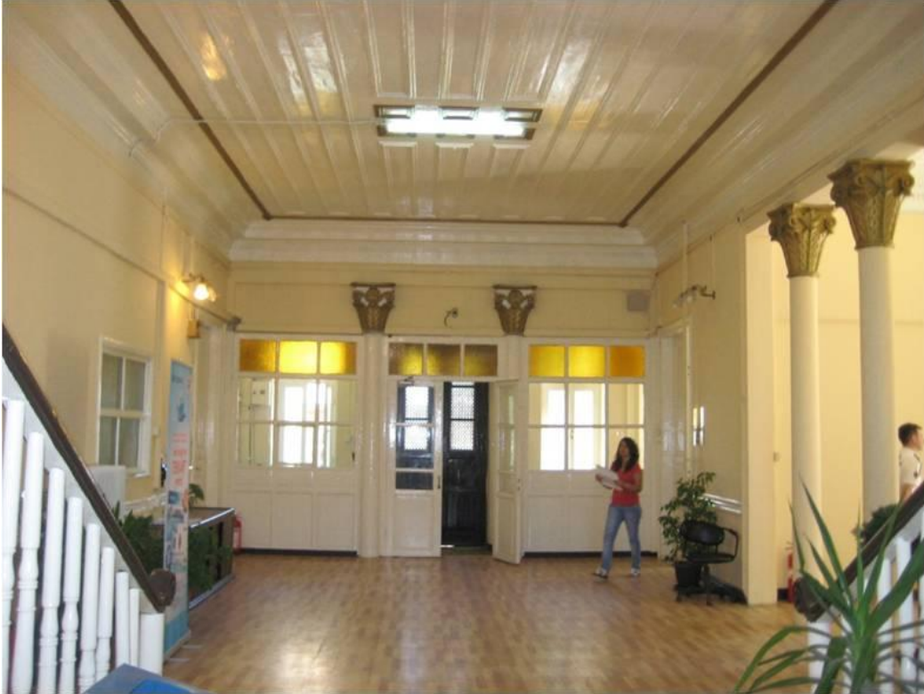
Resim 95: Süleymanpaşa Belediye Binası, restorasyon öncesi zemin kat holü (Çağatay Çavuşoğlu).
