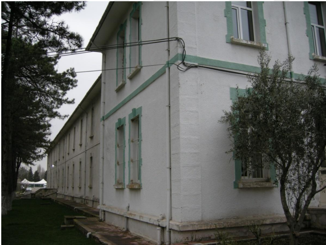
Resim 153: Araştırma ve Uygulama Hastanesi. güneybatı binası batı cephenin güneybatıdan görünümü.
