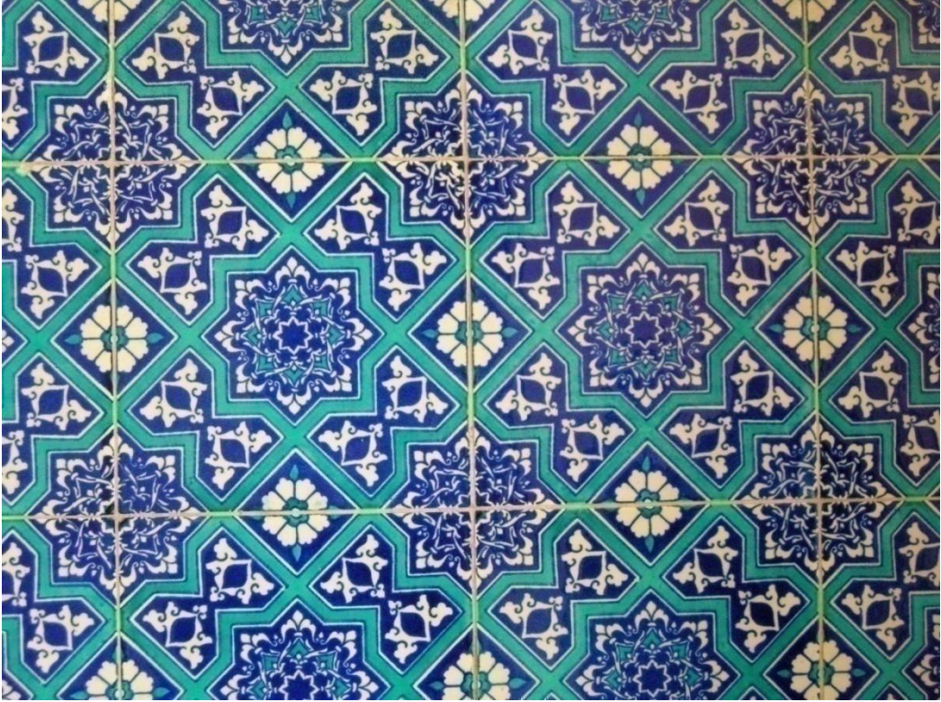
Resim 143: Valilik Binası, giriş holü doğu duvarındaki çini panolardan ayrıntı.
