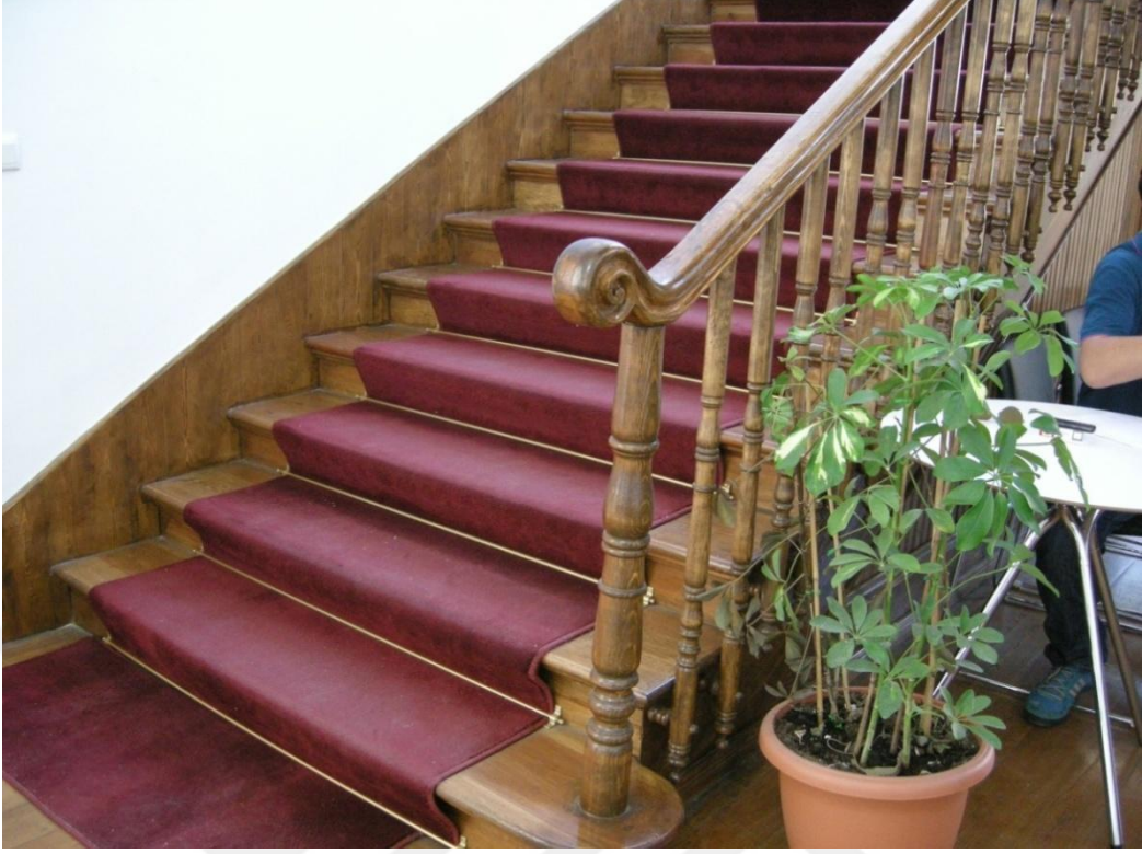
Resim 100: Süleymanpaşa Belediye Binası, restorasyon sonrası zemin kat merdivenlerinin görünümü.
