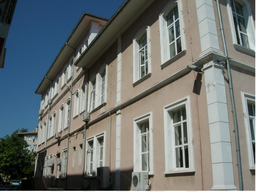
Resim 126: Valilik Binası, batı cephe.
