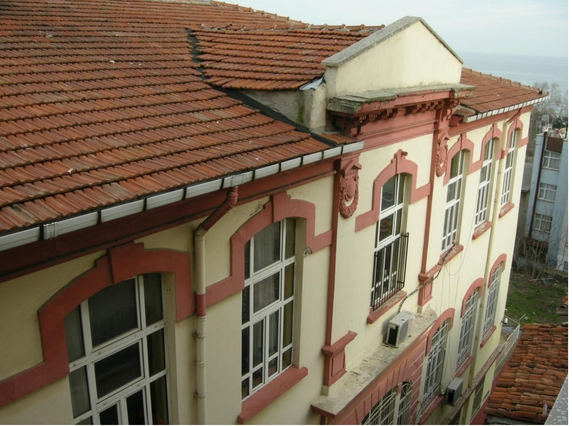
Resim 78: Namık Kemal İlkokulu 1. Kısım, batı cephe.
