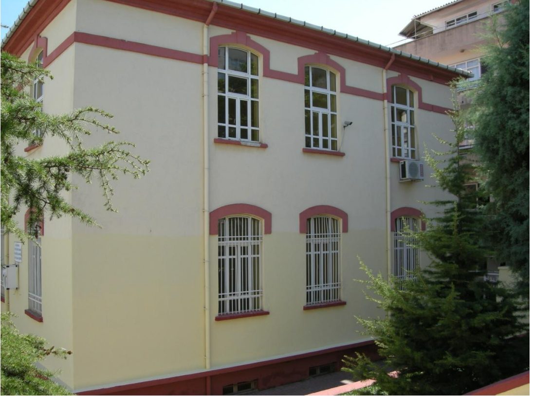
Resim 83: Namık Kemal İlkokulu 1. Kısım, kuzey cephe.
