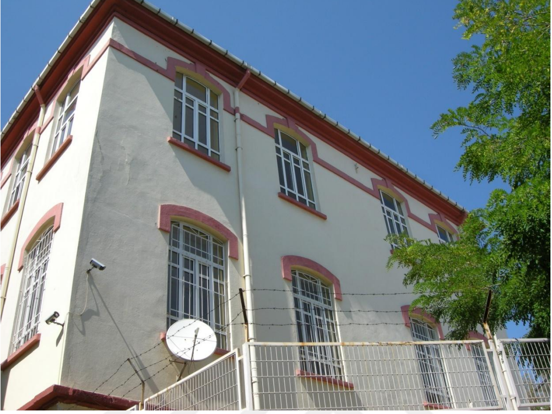
Resim 82: Namık Kemal İlkokulu 1. Kısım, güney cephe.
