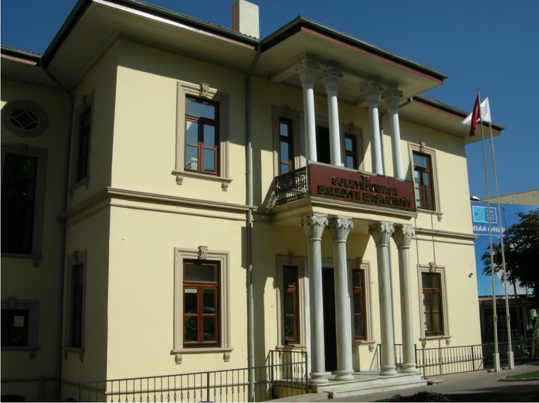
Resim 107: Süleymanpaşa Belediye Binası, batı cephe.
