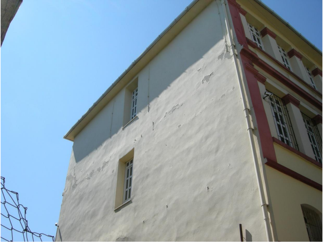
Resim 50: Namık Kemal İlkokulu 2. Kısım, güney cephe.
