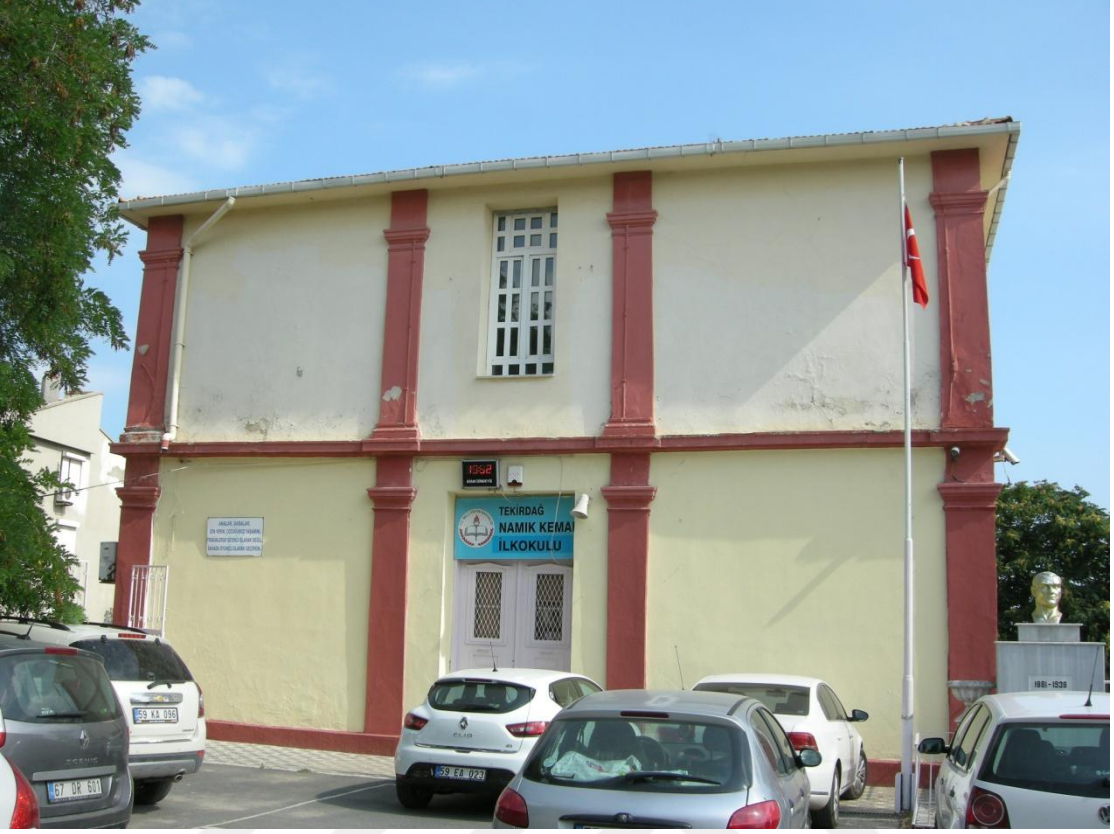
Resim 49: Namık Kemal İlkokulu 2. Kısım, kuzey cephe.
