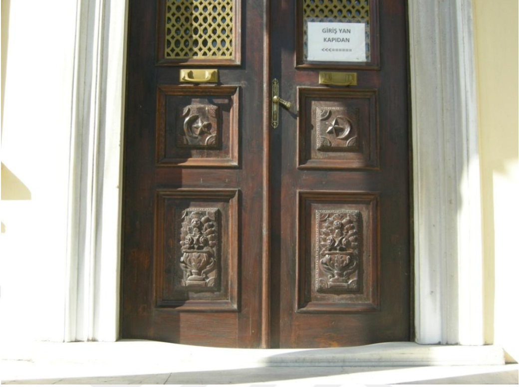
Resim 116: Süleymanpaşa Belediye Binası, güney cephe giriş kapısı detayı.
