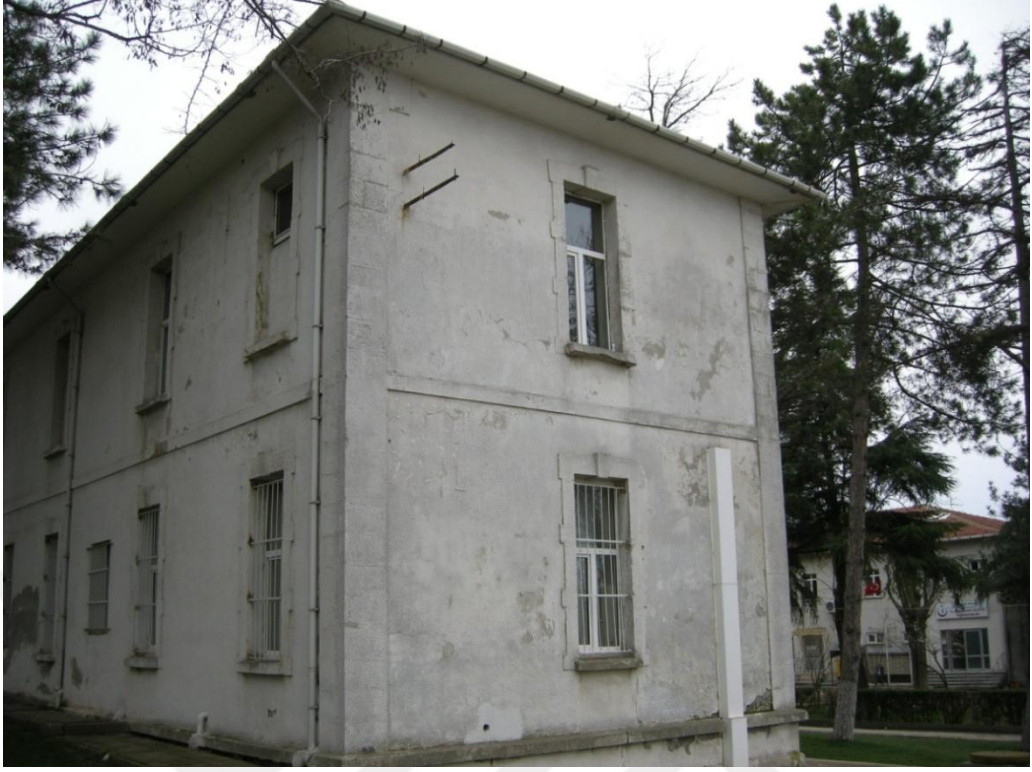
Resim 154: Araştırma ve Uygulama Hastanesi, güneybatı binası kuzey cephe.
