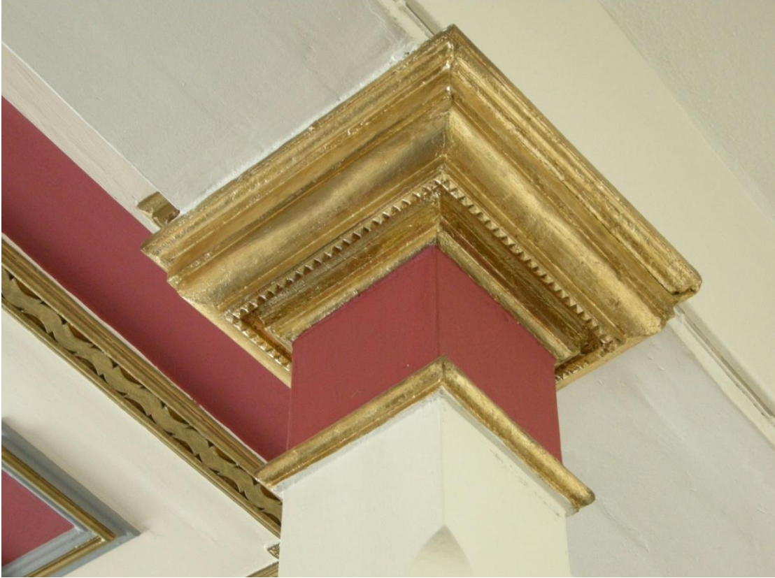
Resim 147: Valilik Binası, giriş holü sütun detayı.
