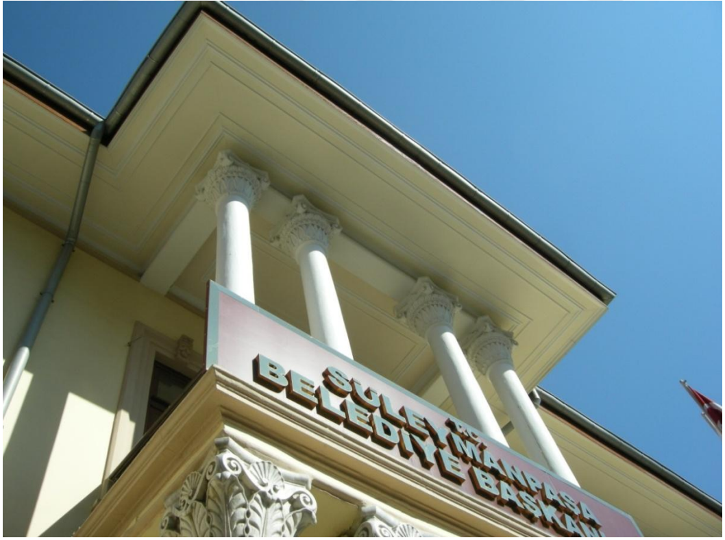
Resim 113: Süleymanpaşa Belediye Binası, batı cephe 1. kat balkon sütunları.
