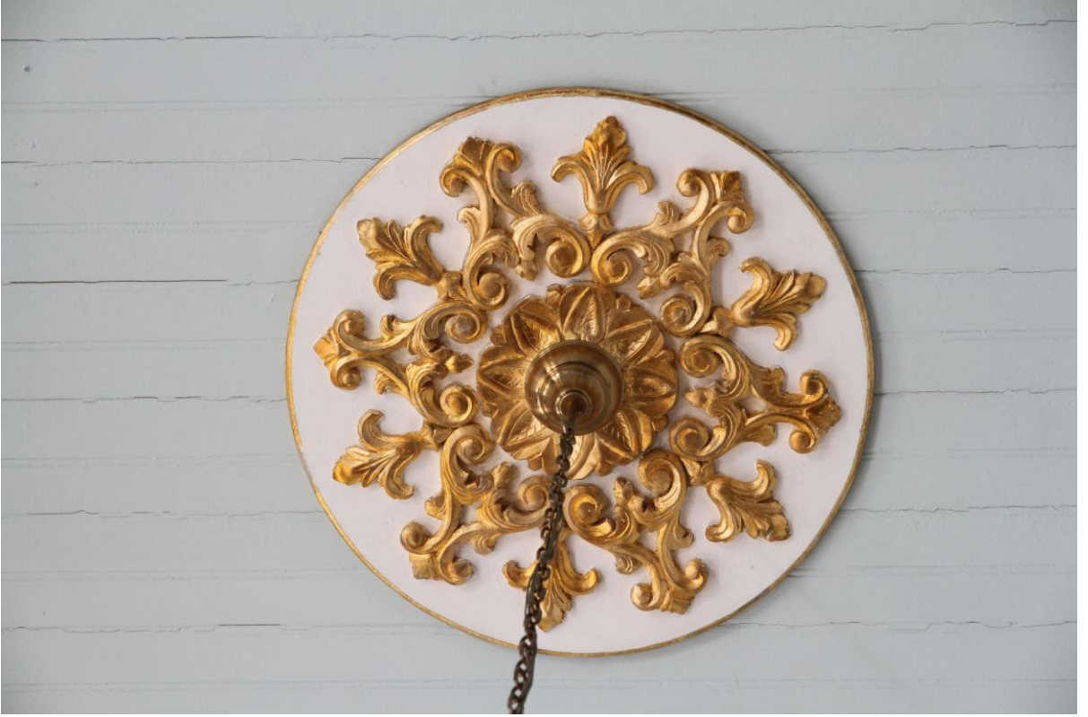
Resim 149: Valilik Binası, 1. kat Vali odası tavan göbeği.
