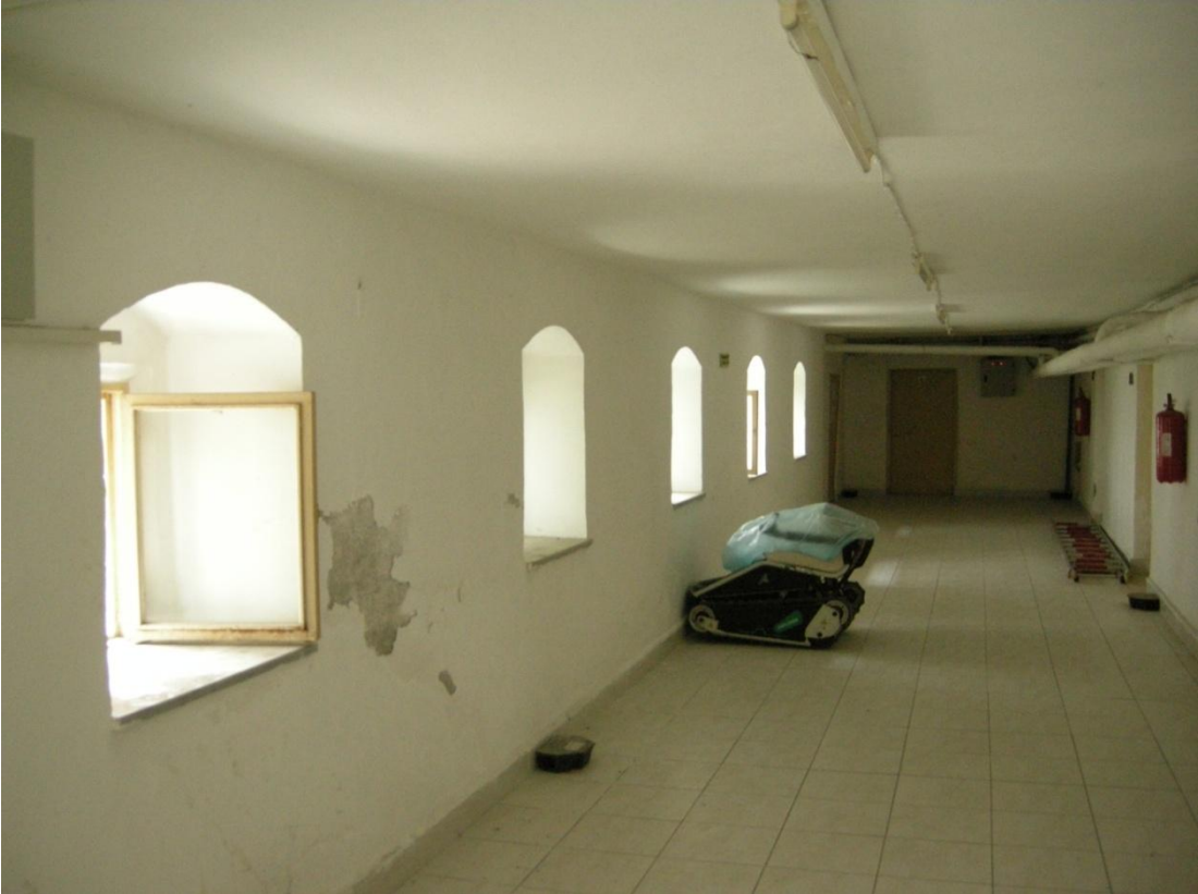
Resim 135: Valilik Binası, bodrum kat kuzey koridoru.
