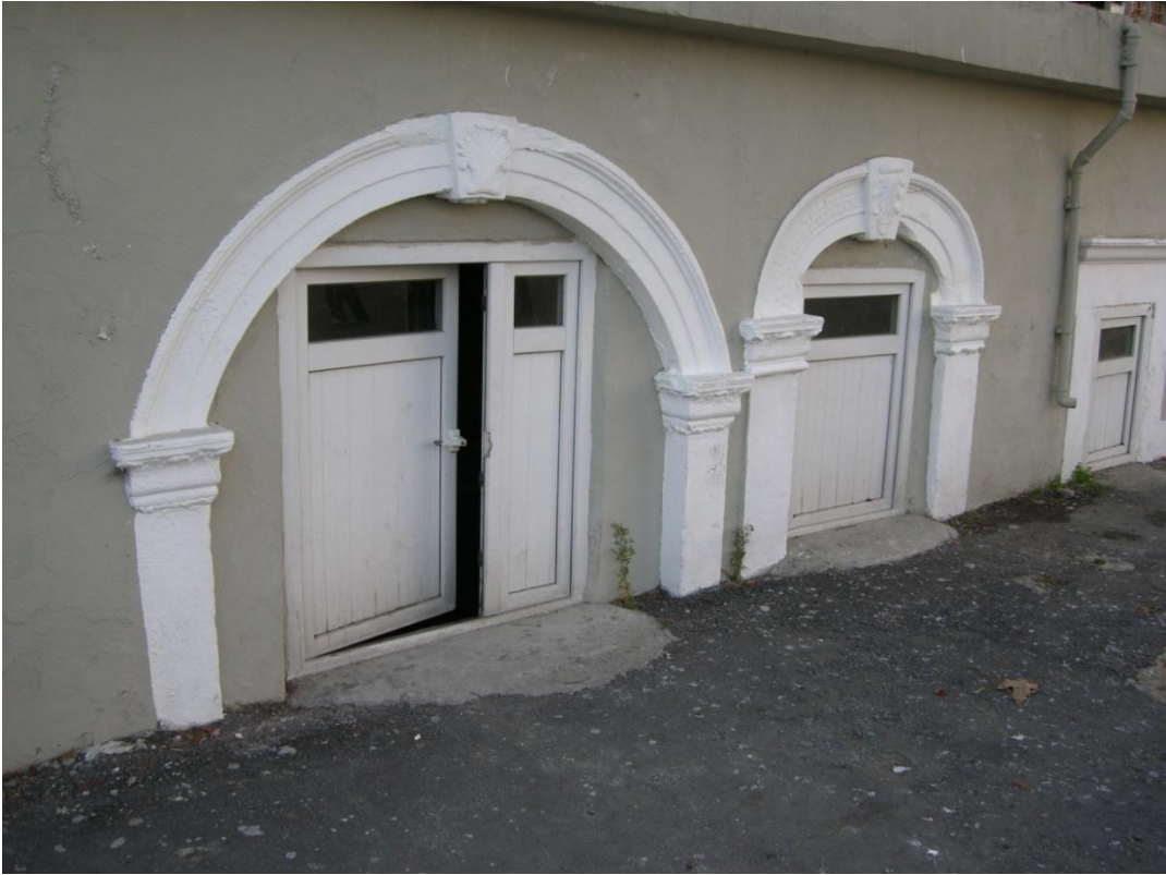
Resim 40: Güzel Sanatlar ve Spor Lisesi, 2. bodrum kat girişi.
