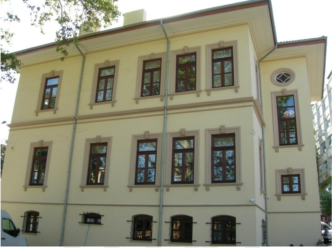
Resim 108: Süleymanpaşa Belediye Binası, doğu cephe.
