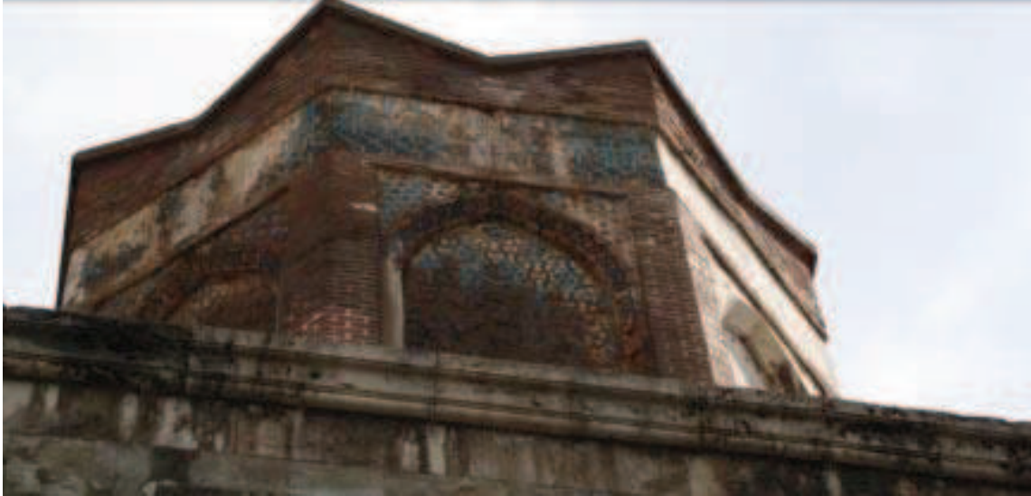
Resim 15. Amasya Gök Medrese Kûlah Kasnağı Çini bezemelerle birlikte kullanılmış sırsız tuğla kaplamaları
