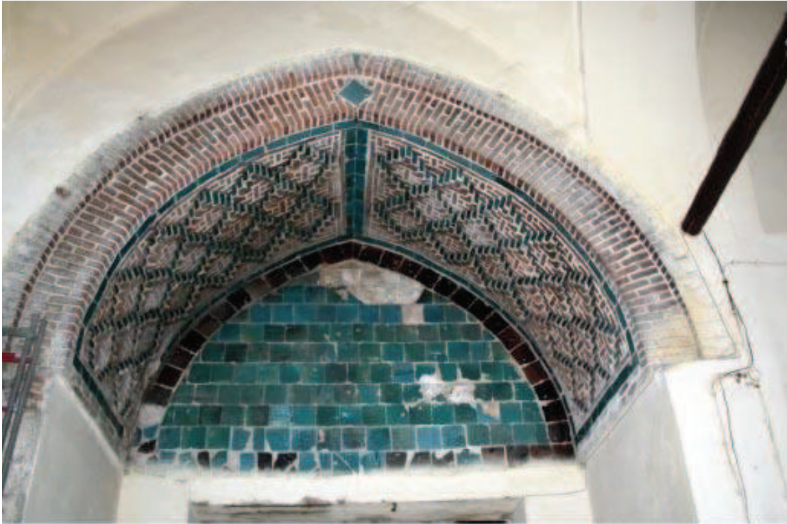
Resim 16. Amasya Gök Medrese Doğu Eyvanı Çini bezemelerle birlikte kullanılmış sırsız tuğla kaplamaları
