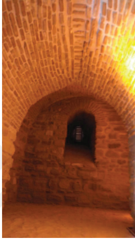
Resim 26. Çimenlik Kalesi iç mekan tuğla tavan kemer
