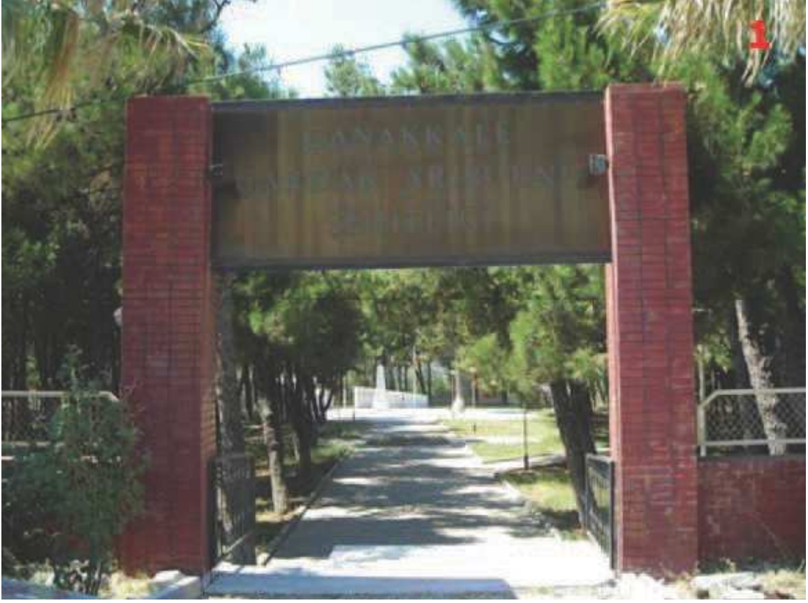
Şekil 2.3. Çardak'taki tarihi yapılar (1 nolu fotoğraf: Arıburnu Şehitliği, 2 nolu fotoğraf: Gazi Yakup Paşa camii, 3 nolu fotoğraf: Gazi Yakup Paşa Hanı).
