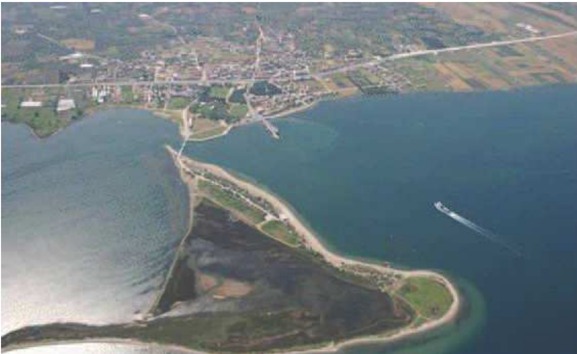
Şekil 2.2. Çardak Beldesi (Lâpseki-Çanakkale)'nden bir görünüm
