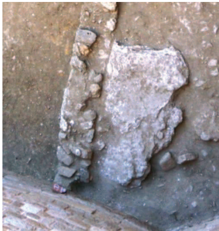
Resim 2.25. Harç taban üstüne, moloz taşlarla örülmüş duvar kalıntısı.
