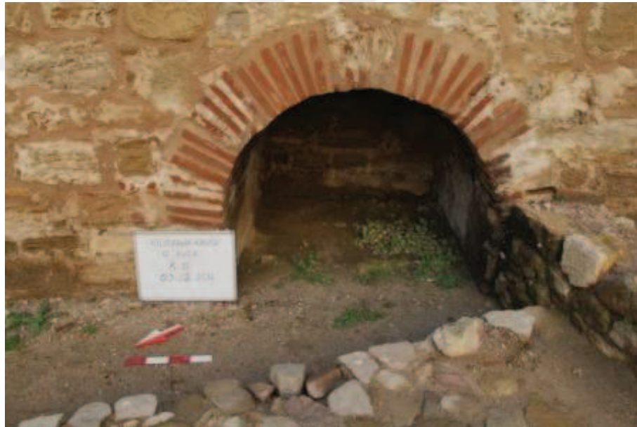
Resim 2.38. Tonoz içinde yapılan sondaj çalışması öncesi.
