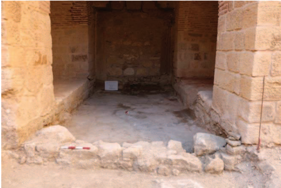
Resim 2.30. K1 Kapısında açığa çıkartılan özgü taş döşeme ile girişinde görülen eşik duvar.
