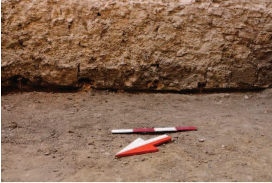
Resim 2.12. Dört köşeli yapının kuzeybatı cephesinde görülen ahşap hatıl parçaları ve in-situ mıhlar.
