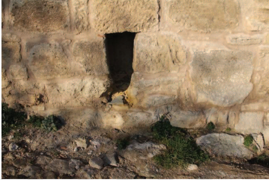
Resim.2.9. Atık su kanalının kalenin dış cephesindeki çıkışı.
