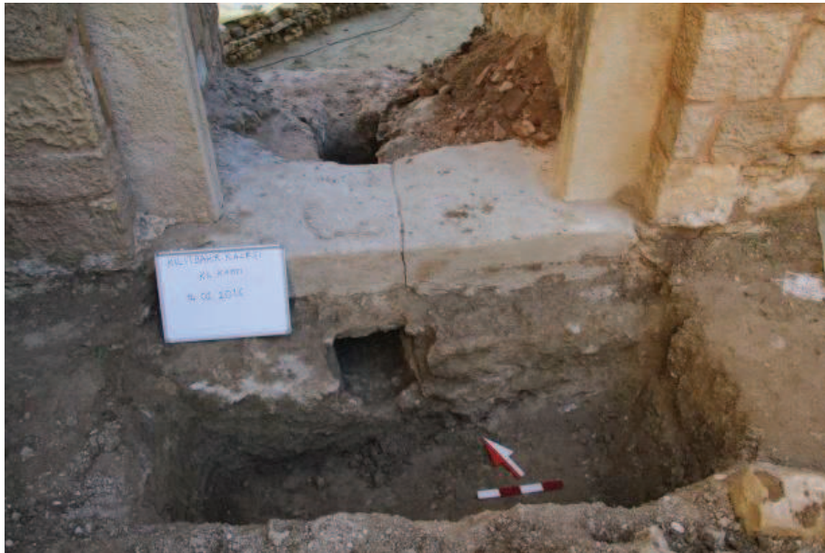
Resim 2.27. B Avlu doğu girişinin eşik taşı altında tespit edilen drenaj kanalı.
