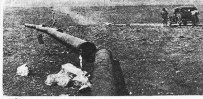
Musul petrollerini Akdeniz sahiline aktaran borular döşenirken
