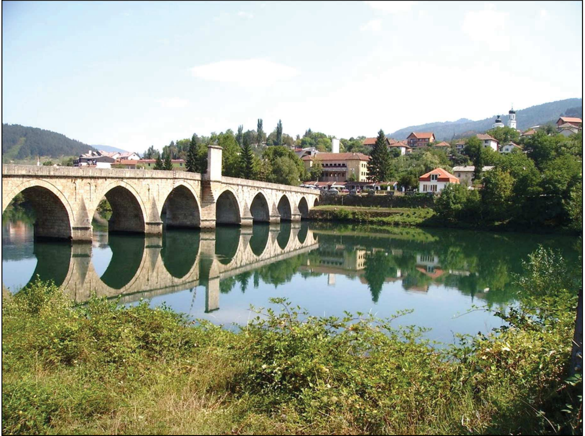
Resim 3.4.: Sokollu Mehmet Paşa Köprüsü/Drina Köprüsü
