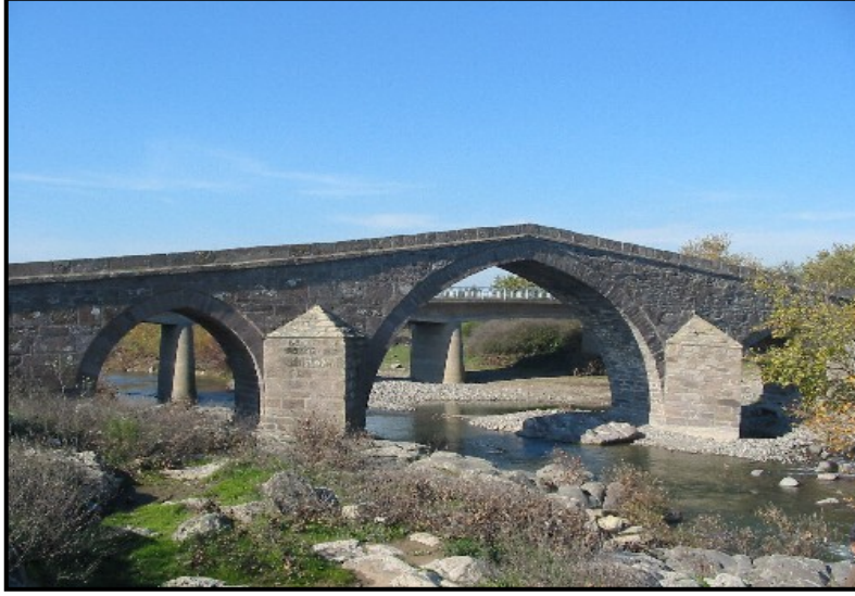
Şekil 5.34. Behramkale (Hüdavendigâr) Köprüsü (Anon., 2004p)
