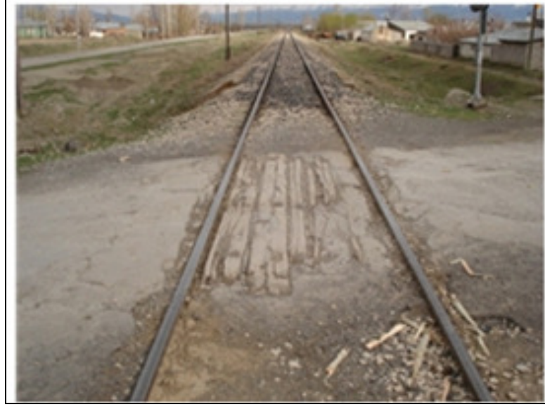
Şekil EK 2.19: Ahşap Travers Kaplamalı Geçit
