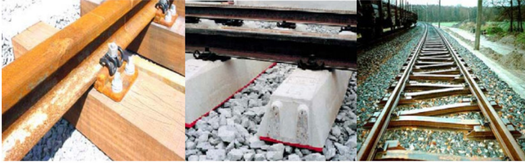
Şekil 2.9 : Ahşap, Betonarme ve Çelik Travers
