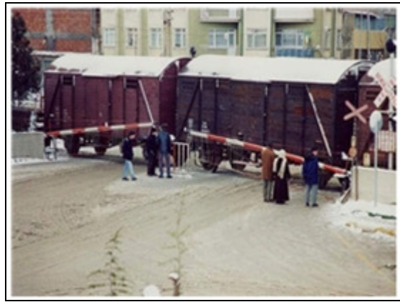
Şekil EK 2.11: Bariyerli-Bekçili Hemzemin Geçit
