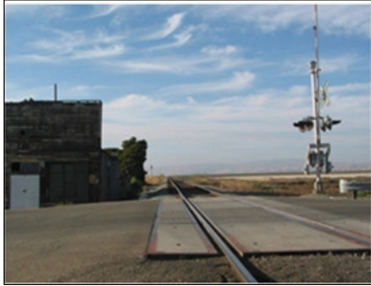
Şekil EK 2.20: Beton prefabrik Kaplamalı Geçit
