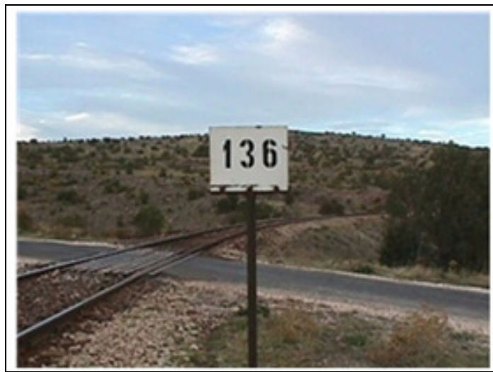
Şekil EK 2.10: Bariyersiz-Bekçisiz Hemzemin Geçit
