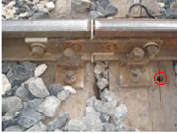
Şekil EK 2.4: İsfine çakılması gereken delik
