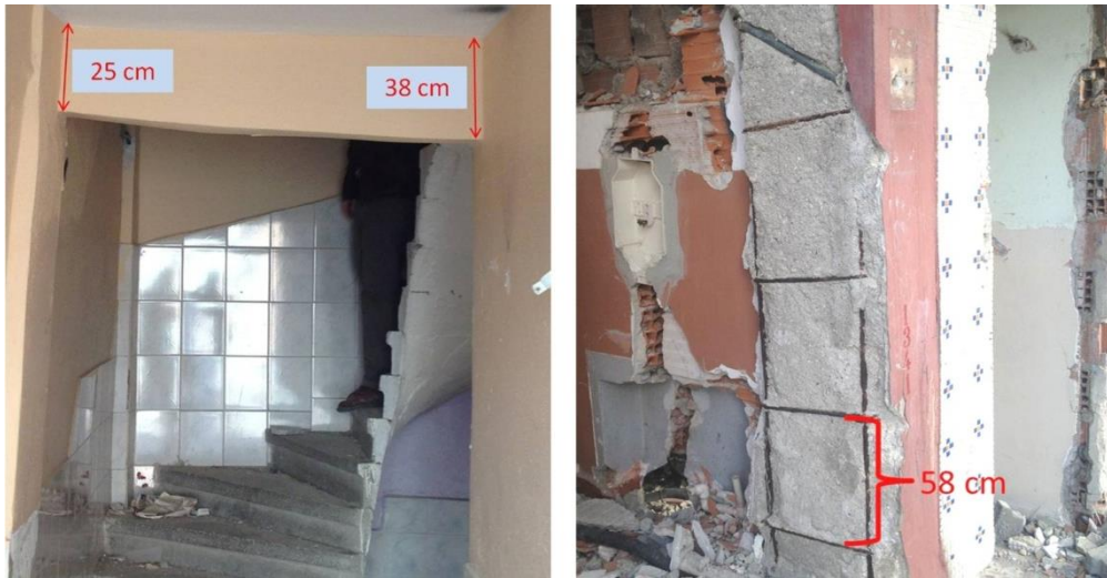
Şekil 5.24: Standartların dışında yapılmış kolonlar
