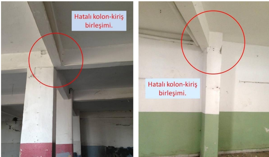
Şekil 5.22: Hatalı Kiriş Birleşimi
