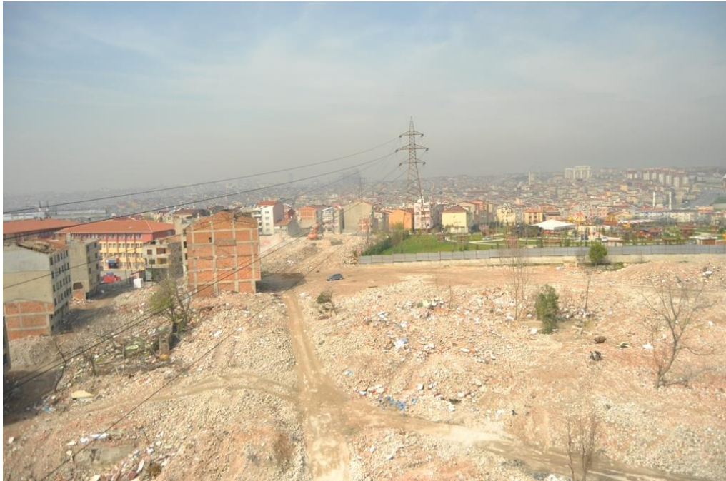
Şekil 5.28: Yıkım Sonrası Alandan Görünüm
