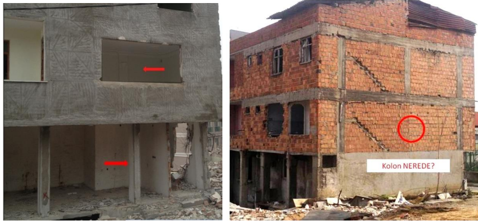
Şekil 5.20: Yapılmayan kolon ve Kesilen kolon
