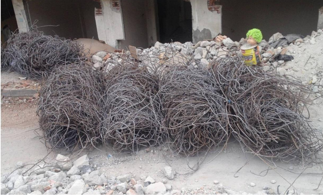
Şekil 5.23: Binalardan çıkarılan demirler
