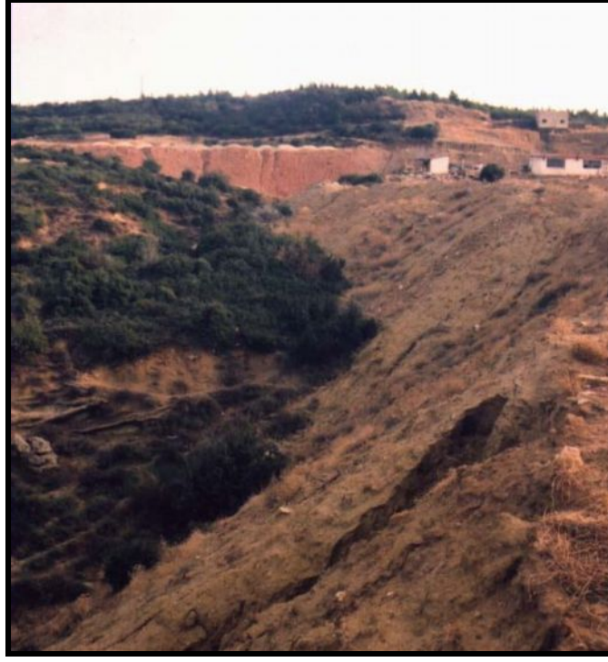
Şekil 5.3. Su Ürünleri Fakültesi Çevresindeki Kabarma ve Çatlaklardan Görünüm (Anon., 2002)
