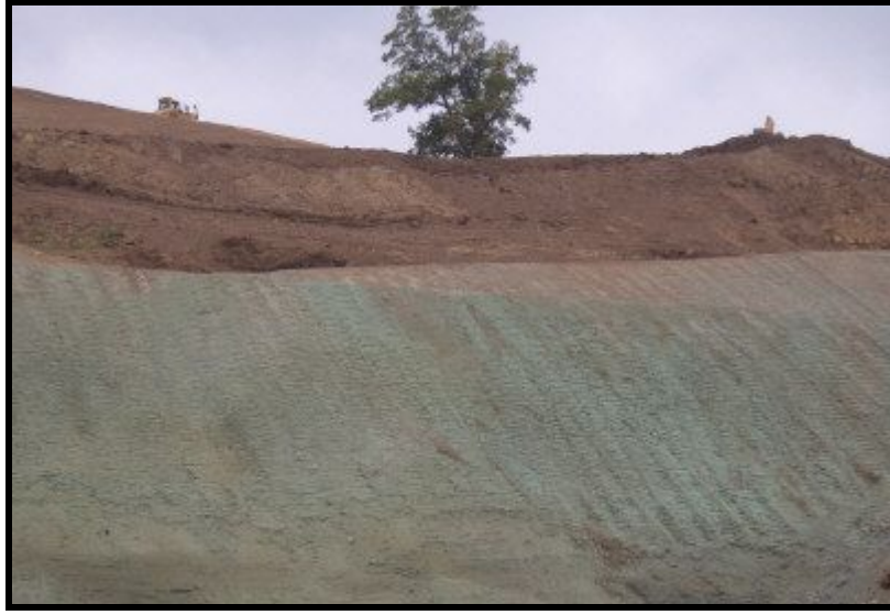
Şekil 3.13. Hydroseeding Uygulanmış ve Uygulanmamış Bir Alandan Görünüm (Anon, 2003c)
