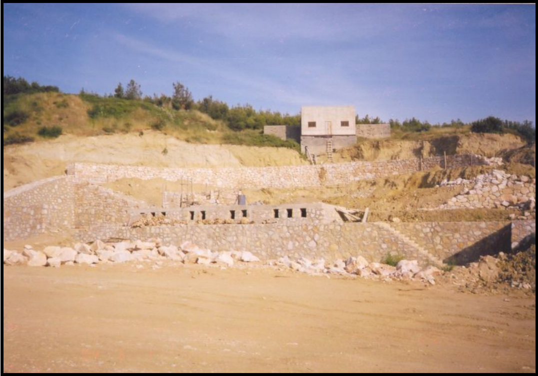
Şekil 5.5. Su Deposunu Destekleyen Amfi Tiyatronun Yapım Aşamasından Görünüm (Anon., 2002)
