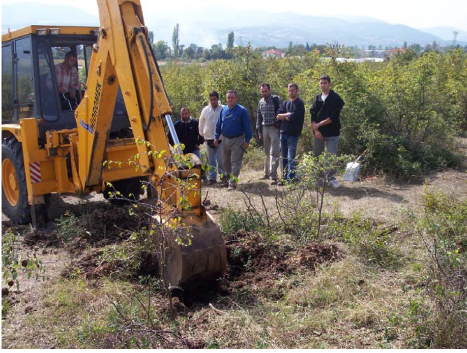
Şekil 4.27. Ketin Hendek Yeri'nde kazı çalışmalarından bir görünüm
