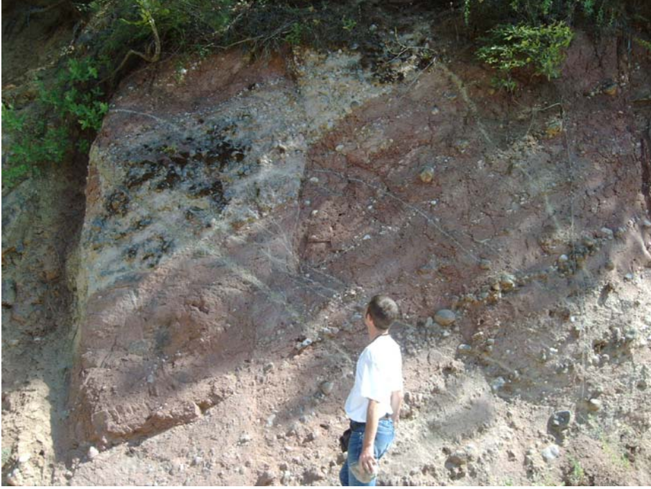
Şekil 2.7. Çal Birimi içerisindeki konglomera seviyeleri ve bunları kesen faylar (Karaköy kuzeyi, Arapuçan dere mevki, UTM Koordinatları: 31410-27123) (KD' dan GB' ya bakış).
