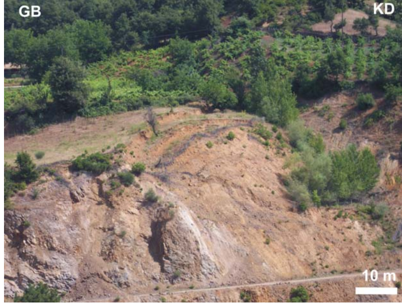
Şekil 4.12. Karasukabaklar–Güzeloba köyleri arasında, Yenice-Gönen asphaltındaki güncel heyelanlar (GD'dan KB'ya bakış).
