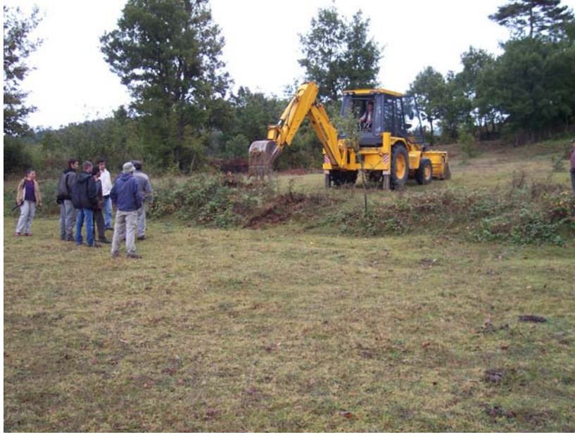
Şekil 4.44. Yenice-Gönen Fay Sarplığı üzerindeki Seyvan Hendeği kazı çalışmaları (Kuzey'den Güney'e bakış).
