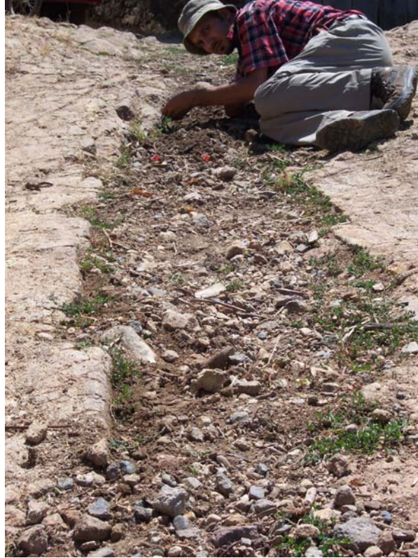
Şekil 4.11. Karasukabaklar köyü camii içerisindeki K60B gidişli yüzey kırığı (GD'dan KB'ya bakış).
