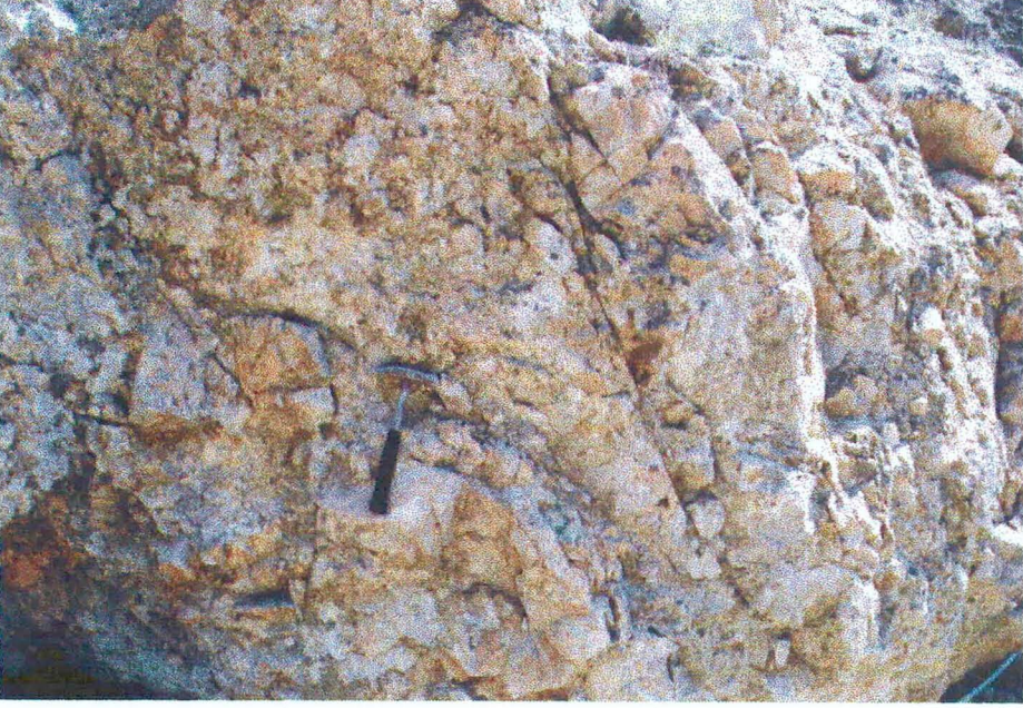
Şekil 2.12. Sarımsı-beyaz renkli aşırı silisleşmiş tuf bileşenli piroklastik breşler (Koru şantiyesi, Tahtalıkuyu ocağı girişi üst seviyeleri).
