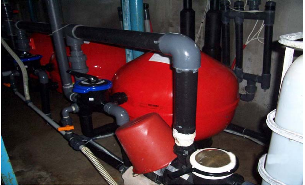
Sistemde Kullanılan Kum Filtreleri
