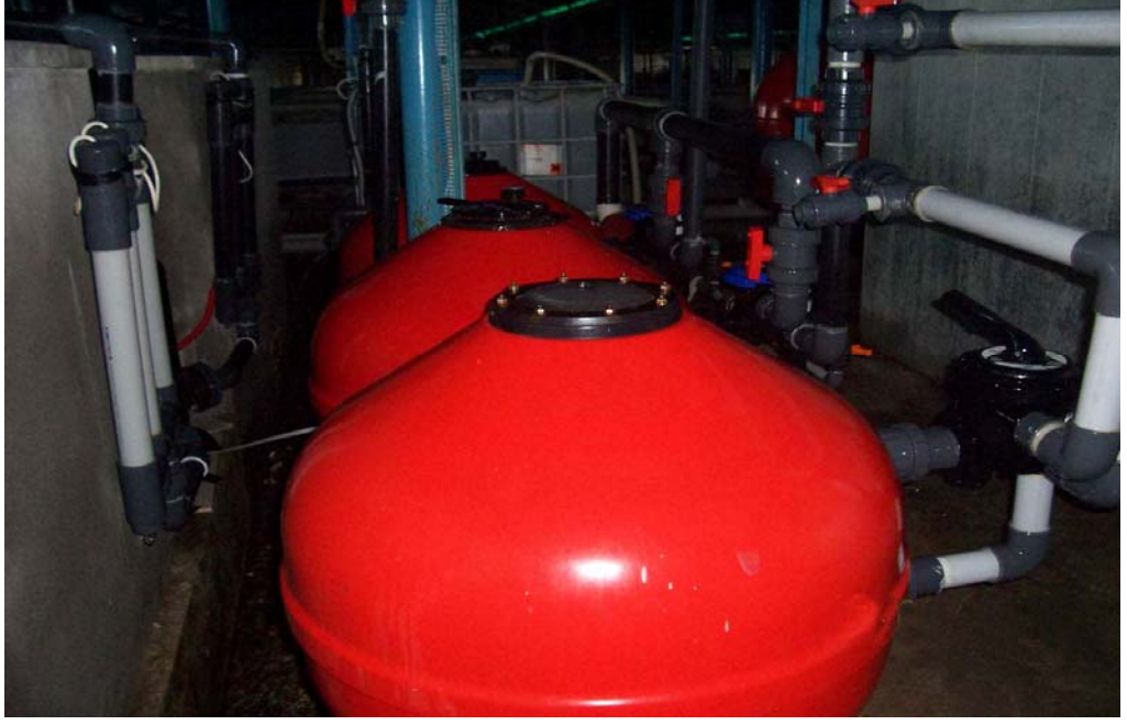
Sistemde Kullanılan Biyolojik Filtre
