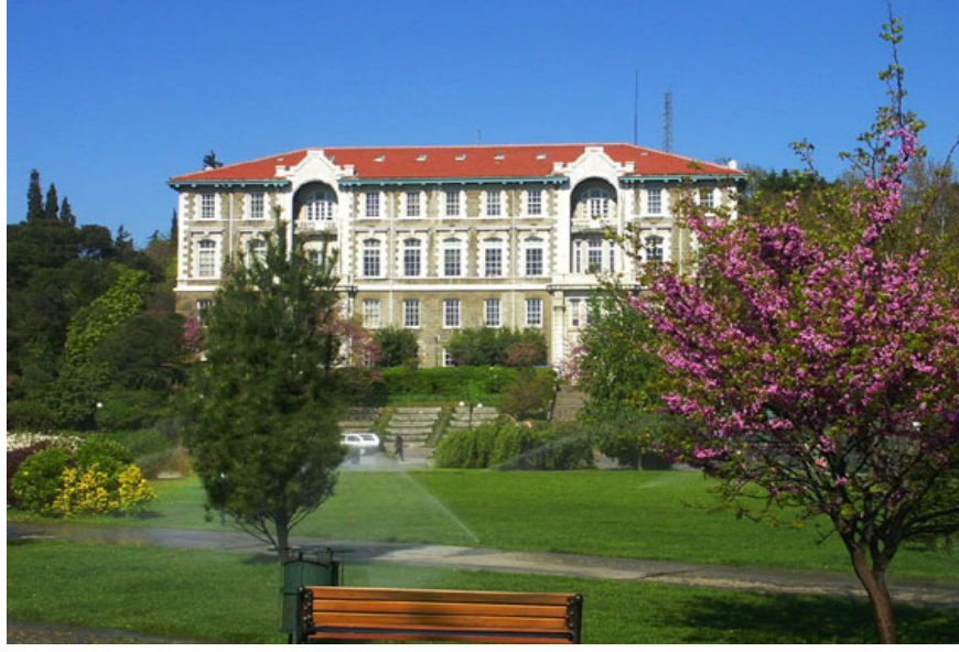
Şekil 3.24. Boğaziçi Üniversitesi Güney Yerleşkesinden Bir Görünüm (Anonim, 2005b)
