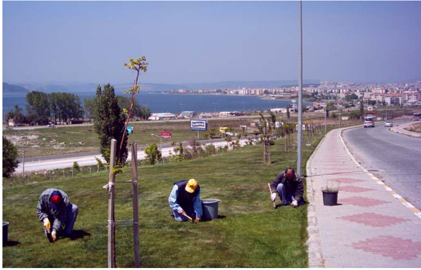
Şekil 5.27. Yol Kenarı Bitkilendirmesi ve Bakım Çalışmaları (Özgün, 2005)
