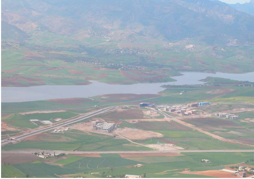
Şekil 3.32. KSÜ Avşar Yerleşkesi (Bodur ve diğ., 2005a)
