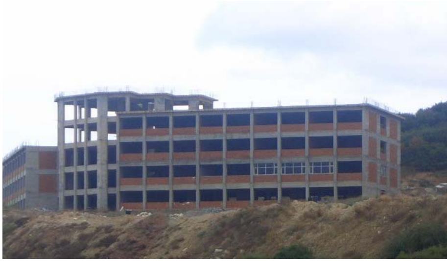
Sekil 5.12. Mühendislik-Mimarlık Fakültesi Bina İnşaatı (Özgün, 2005)
