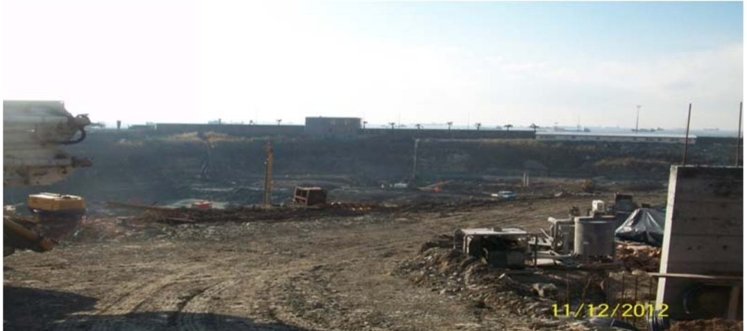
Şekil 4.44: Delta inşaat rezidans projesi
