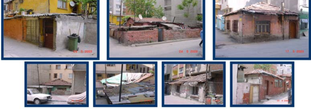
Şekil 4.20: Zeytinburnu ilçesinde bulunan gecekondulara ait fotoğraflar
