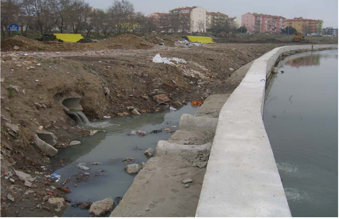
Resim 11. Sarıçay’ da 7. istasyonda bulunan yağmur kanallarına karışan evsel atık sular.
