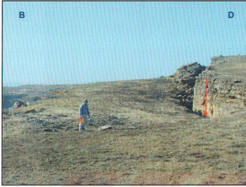
Şekil 5-18: Kaşınbaşı Sirtının BGB ucunda travertenlerde gözlenen çöküntü alanı
