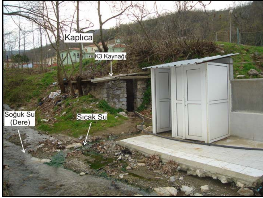
Şekil 4.27. Kırkgeçit deresine boşalan K3 kaynağı
