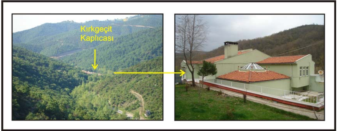
Şekil 4.2. Kırkgeçit kaplıcasının GB'dan kuşbakışı görünümü ve kaplıca tesisleri
