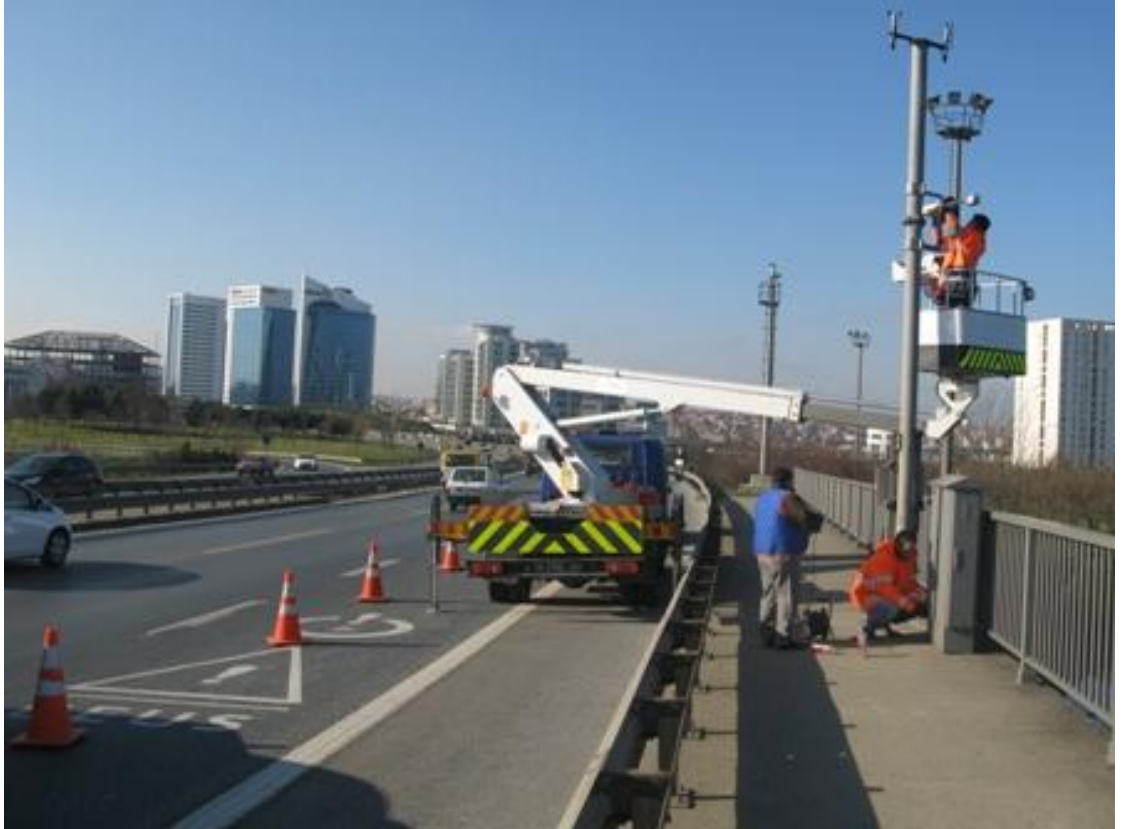
Şekil 4.13: BEUS bakım çalışması
