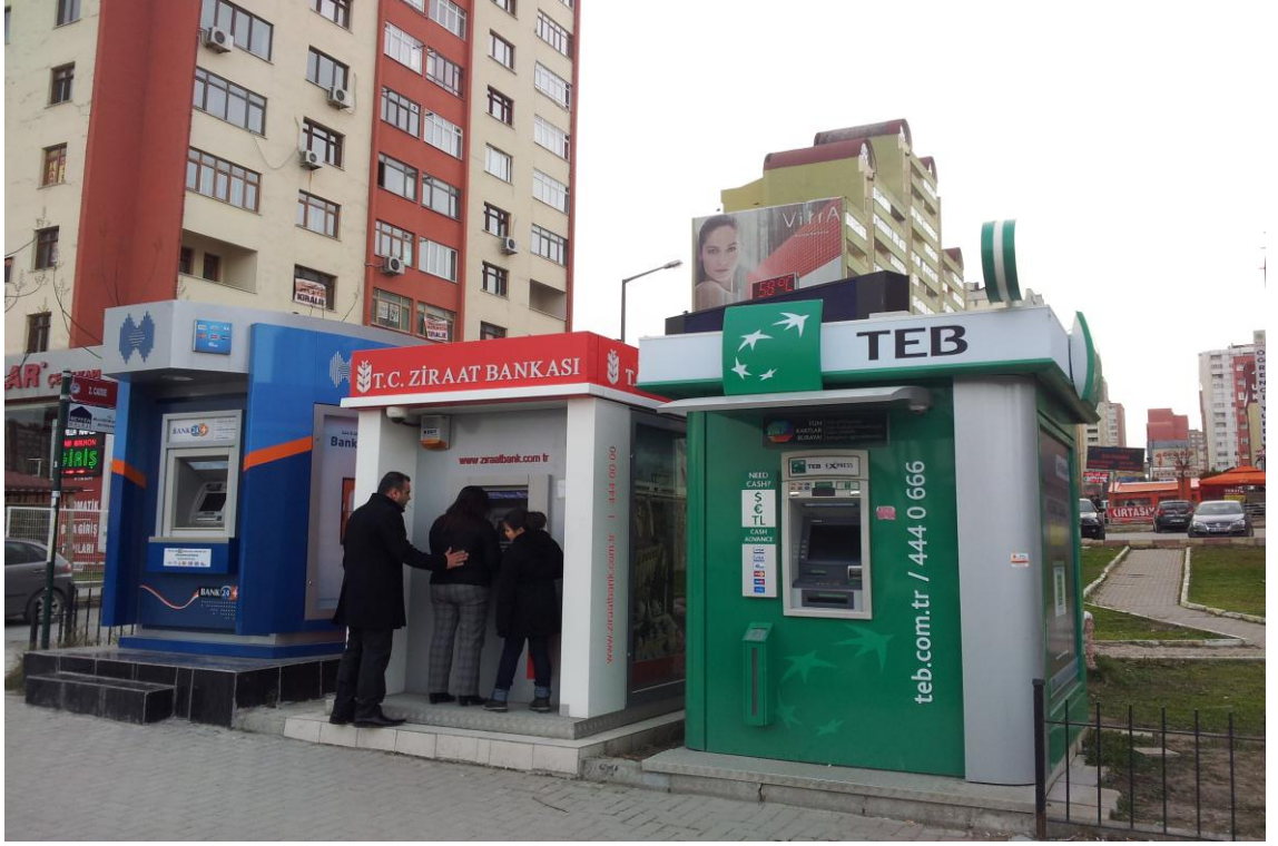
Şekil 10. 16: Esenyurt Cumhuriyet Mahallesi genel görünüm
