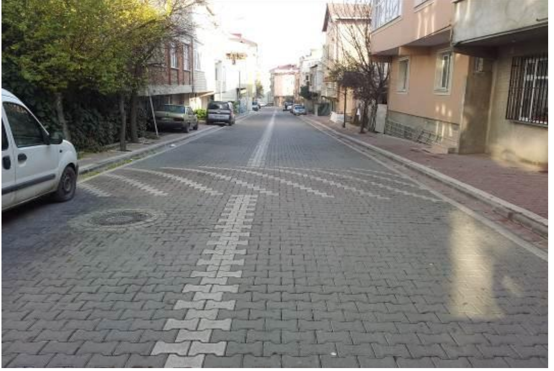
Şekil 10. 38: 905. Sokak genel görünüm
