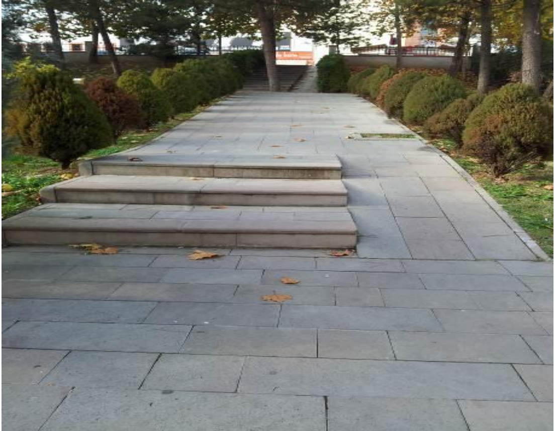
Şekil 10. 59: Hasbahçe Parkı genel görünüm
