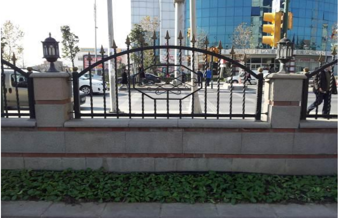
Şekil 10. 56: Belediye Bahçesi genel görünüm
