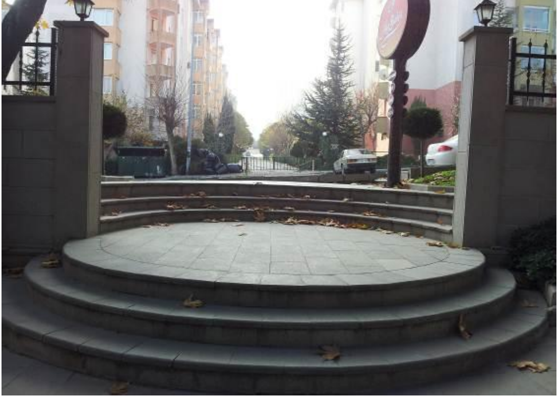
Şekil 10. 58: Hasbahçe Parkı genel görünüm
