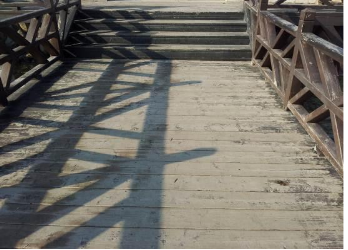
Şekil 10. 48: M. Akif Ersoy Parkı genel görünüm
