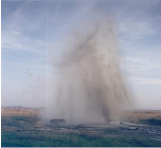
Şekil 4. Dikili-Kaynarca Sahasında Kontrolsüz Açılan Sondaj (Karahana, 2006)
