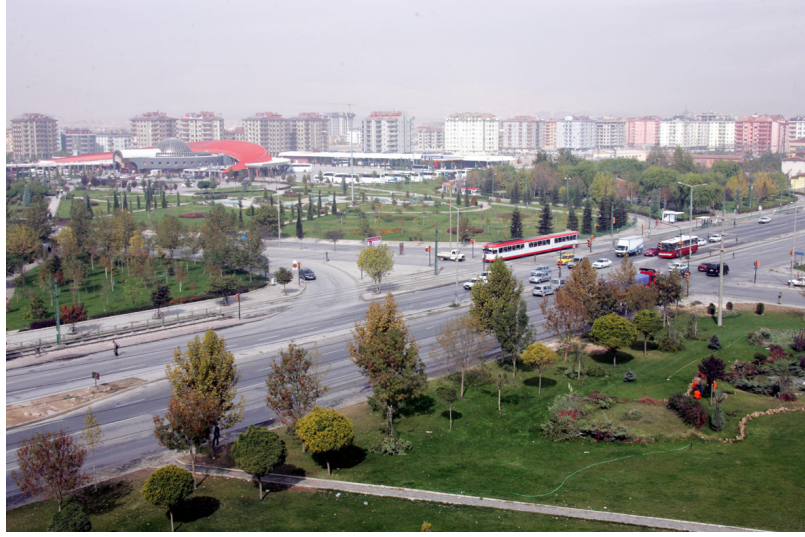
Şekil 5.18. İstanbul yolu otopar kavşağından görünüm (Anonim, 2008e)
