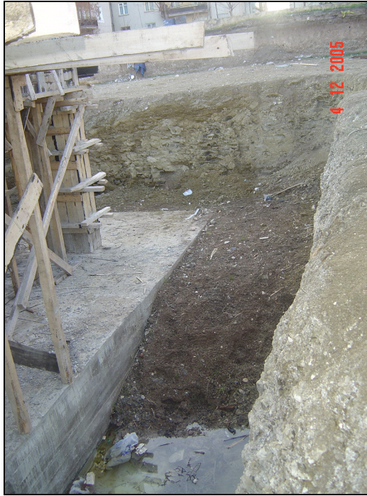
Şekil 2.18. Marnlar üzerine temel inşaatı (Kılavuz mah)
