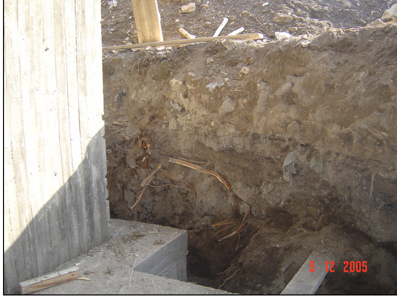
Şekil 2.19. Dolgu ve alüvyon malzeme üzerine inşa edilen bir temel (Gökmedrese Mahallesi).
