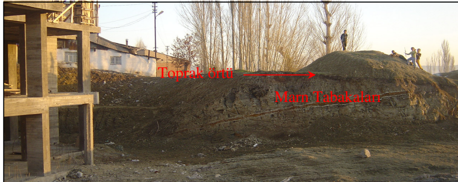
Şekil 2.16. Kılavuz mahallesi vali konağı yukarısında temel inşaatı ve marn tabakaları
