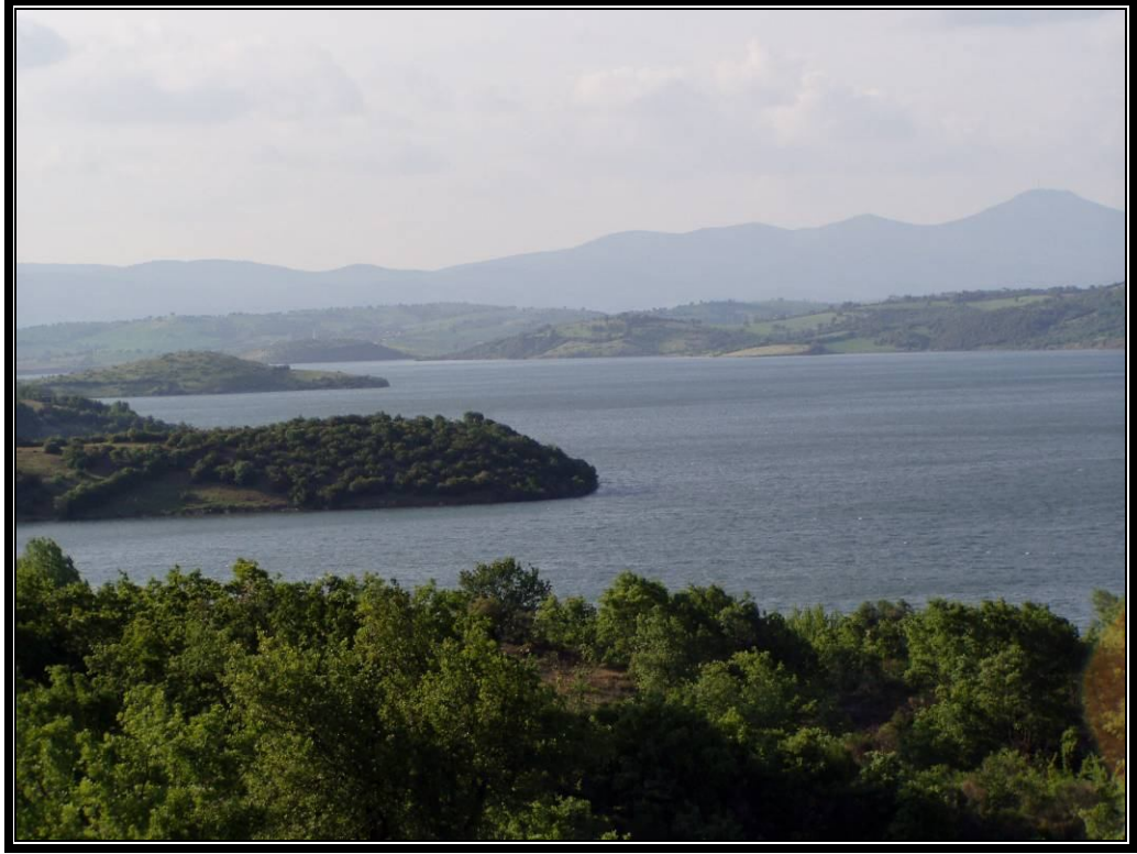
Şekil 5.8. Bayramiç Barajı'na ait bir görünüm (Mayıs-2005).
