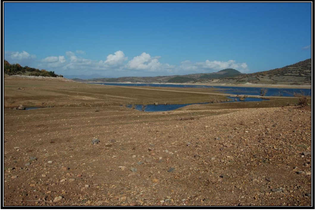
Şekil 5.10. Bayramiç Barajı'na ait bir görünüm (Ekim-2008).
