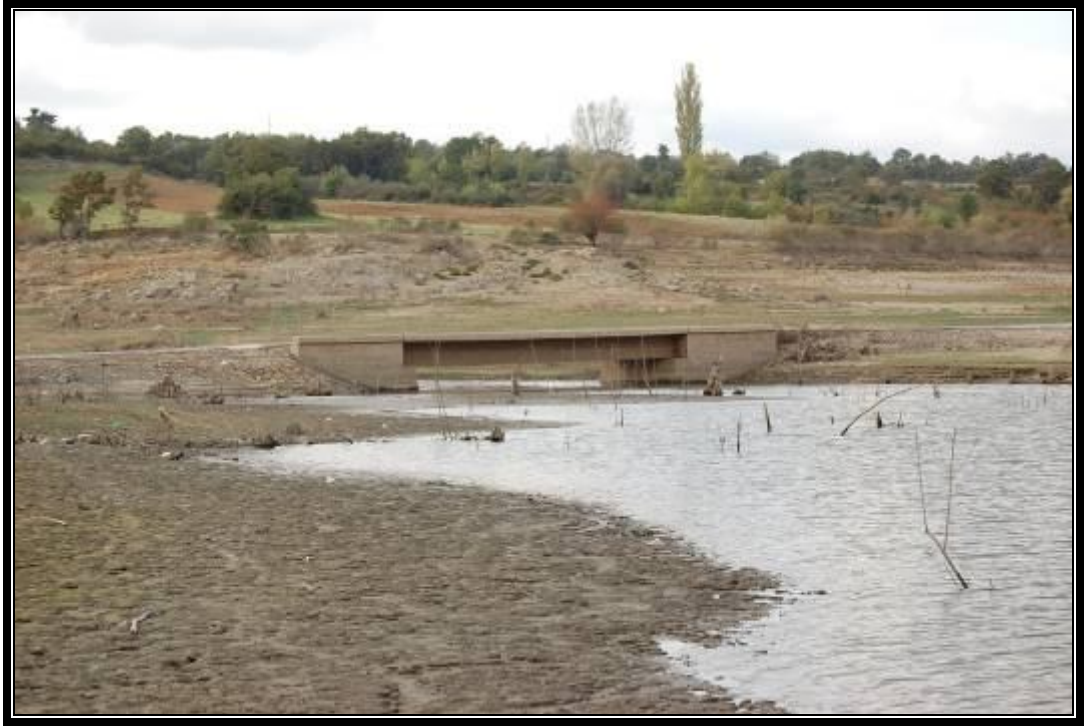
Şekil 5.15. Göl suyunun çekilmesi sonucu açığa çıkan eski Kurşunlu Köprüsü.
