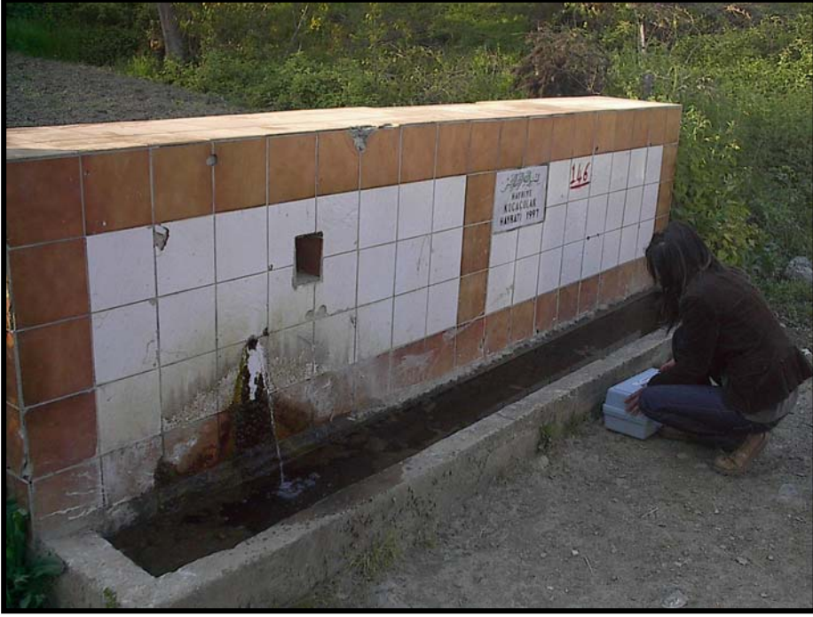
Şekil 4.3. Çalışma sahasındaki Ç007 no'lu soğuk su kaynağının yanındaki çeşme (Kulfa köyü; 449154-4431359).
