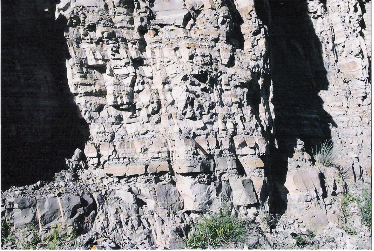
Foto 1: Çalışma alanındaki Filiş'ten görünüm.
