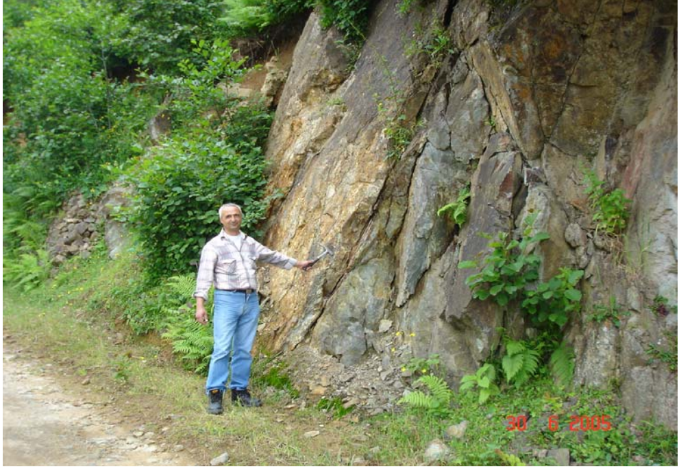
Şekil 3.9. D-6 damarının yüzeyde ileri derecede bozunmuş halde görünümü
