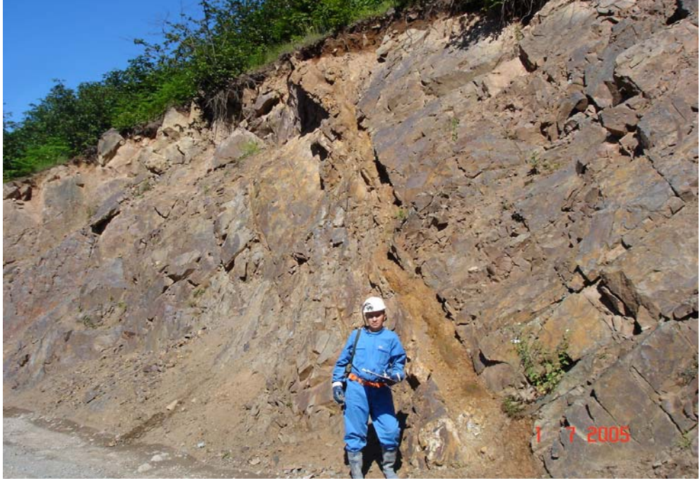
Şekil 3.7. D-4 damarının yüzeyde ileri derecede bozunmuş halde görünümü
