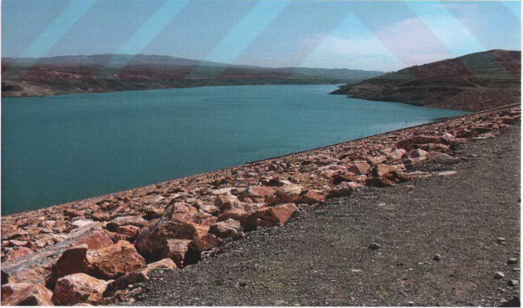
Şekil 5.2. 4 Eylül Barajından Genel Görünüm (Doğu-Kuzeydoğu/Soğuk çermik tarafına bakış)
