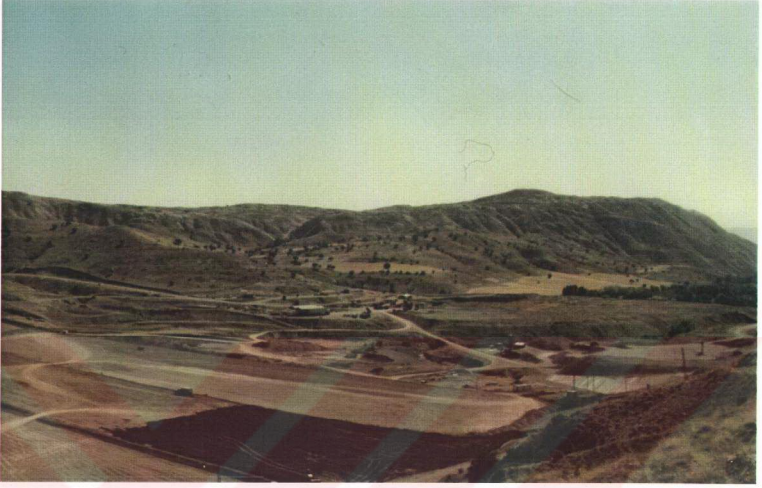
Şekil 5.1. 4 Eylül Barajı Yapım Aşamasından Bir Görünüm (Doğuya / Soğuk çermik tarafına bakış)
