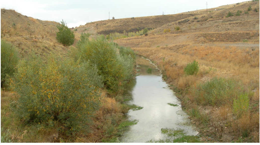
Şekil.2.26. 4 Eylül Barajı Mansabı
