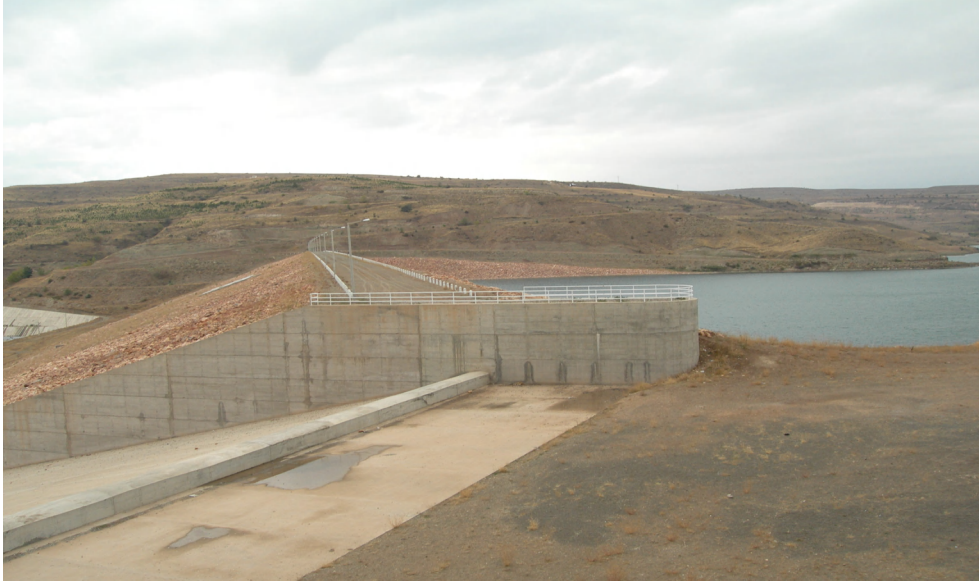
Şekil 2.23. Betonla kaplanmış dolu savak
