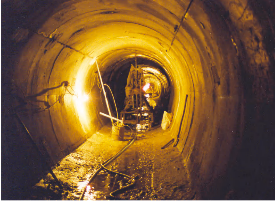
Şekil 2. 22. Derivasyon tüneli inşaatından bir görünüm ve öngörülen destekleme sistemi
