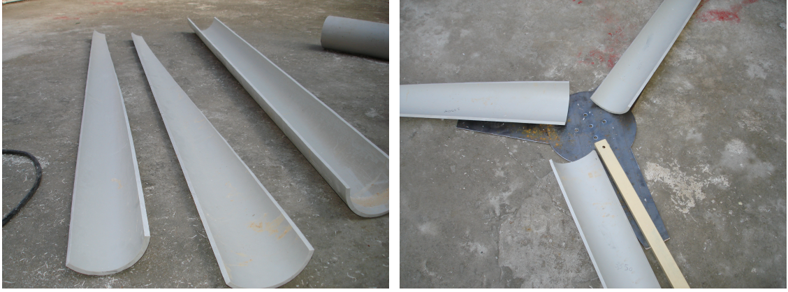
Şekil 45. PVC kanatların yapılması.
