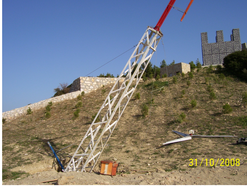
Şekil 48. Türbin direğinin dikilmesi.
