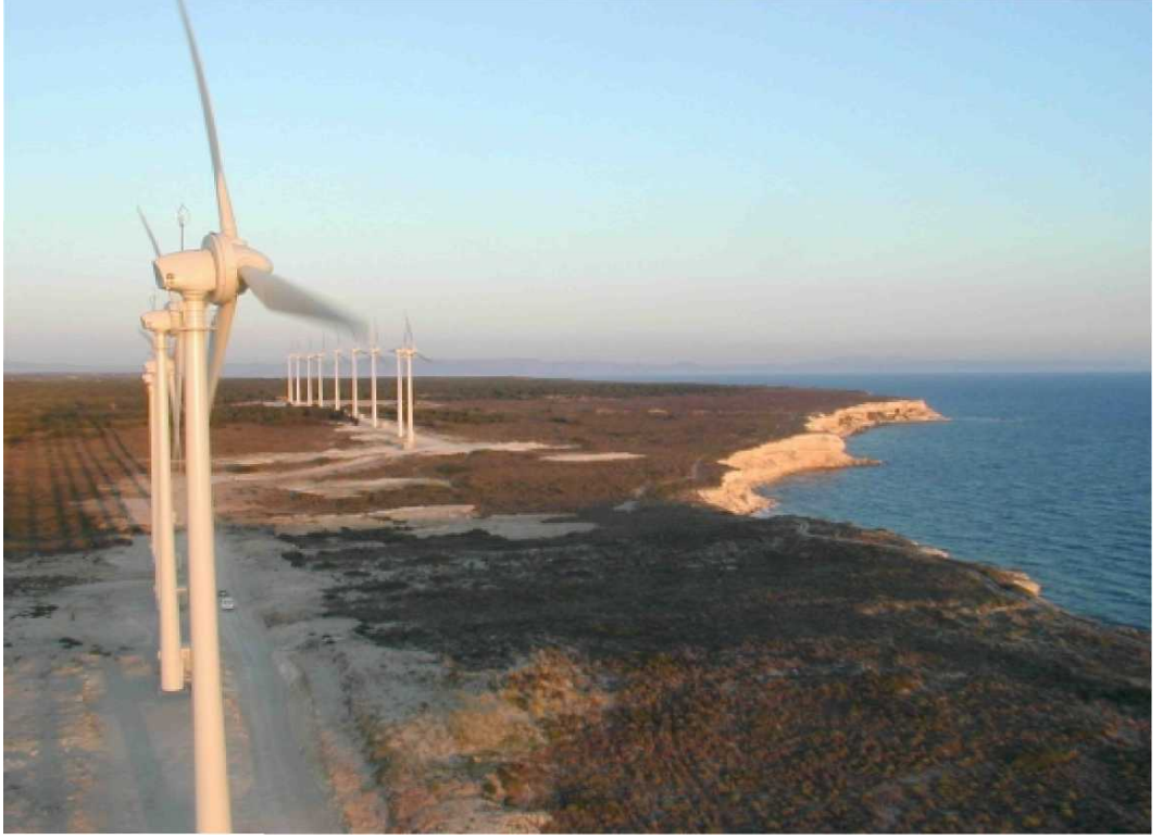
Şekil 2.12– Bozcaada rüzgar santrali, 17 x 600 KW = 10.2 MW Haziran 2000
