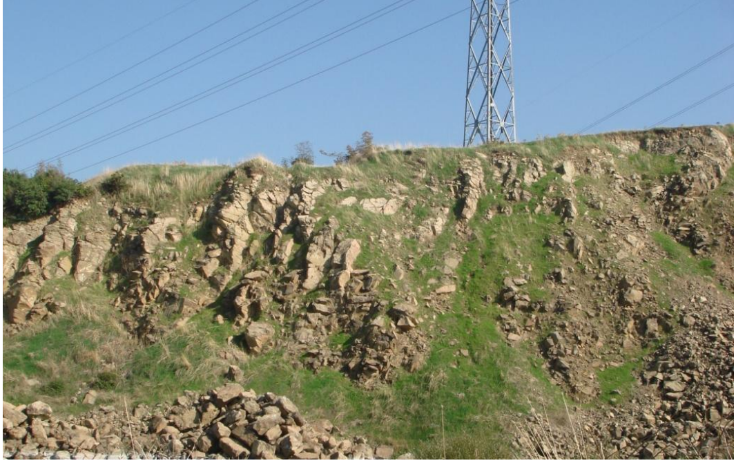
Şekil 29. Akçalar Beldesi atık depolama sahası civarında bulunan, Triyas yaşlı bazik volkanik kayalara ait iyi gelişmiş çatlak sistemleri (Bakış Yönü: Kuzeybatı'dan Güneydoğu'ya; UTM: 35 T 0648747E, 4447106N).
