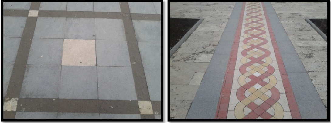
Şekil 3.47: Akpınar Meydanı zemin döşemesi
