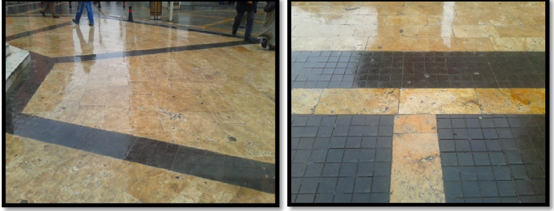
Şekil 3.24: PTT Meydan döşemesi.
