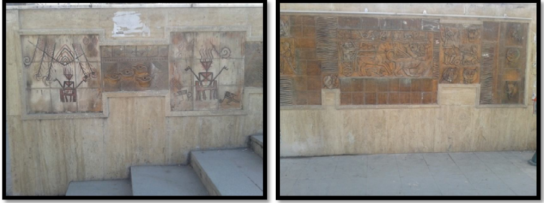
Şekil 3.33: Kapalı çarşı duvarında rölöve çalışması
