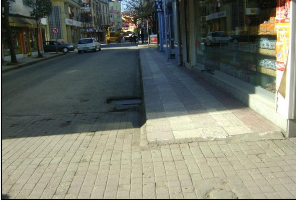
Şekil 5. 1. Sırrıpaşa Caddesi üzerinde bulunan kaldırım.
