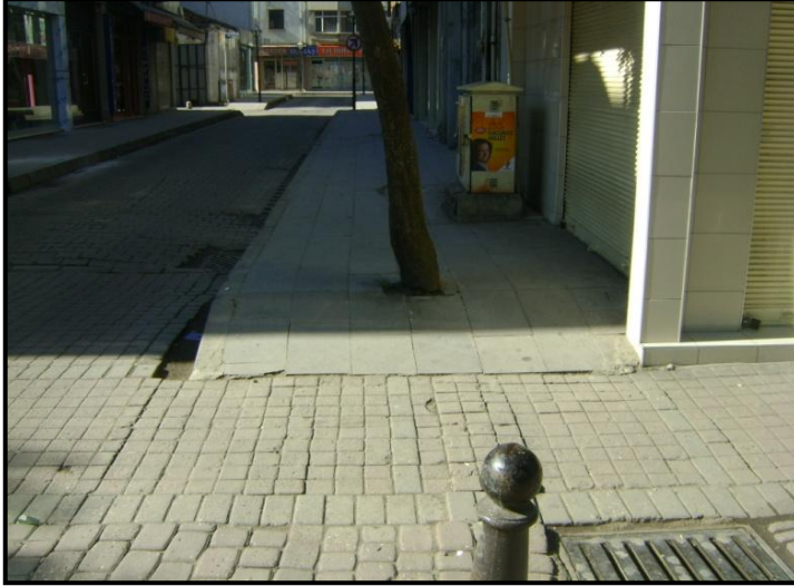
Şekil 5. 4. Sırrıpaşa Caddesi üzerinde kullanıma uygun olmayan kaldırım.
