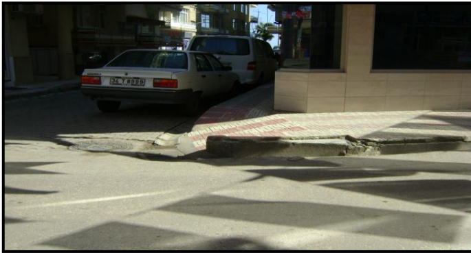
Şekil 5. 6. Süleyman Felek Caddesi'nde kaldırım rampası örneği.
