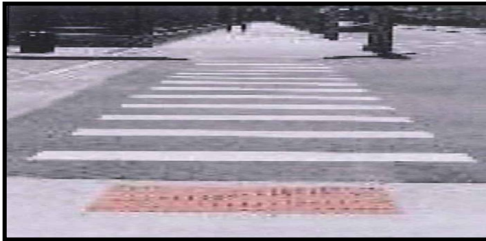
Şekil 3. 48. Rampaya yerleştirilen kaymayı önleyici yüzey kaplaması (Eyüboğlu, 2008).
