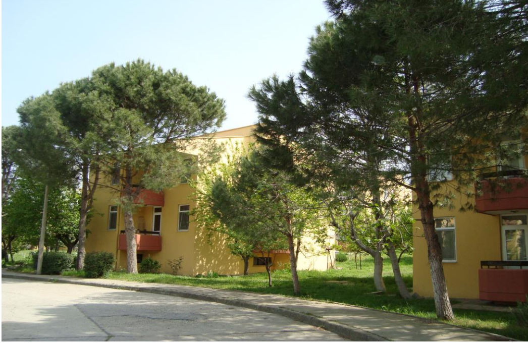
Şekil 5.40. Hürriyet Mahallesinde yer alan S.E.A.Ş. lojmanları (Özgün, 2010).
