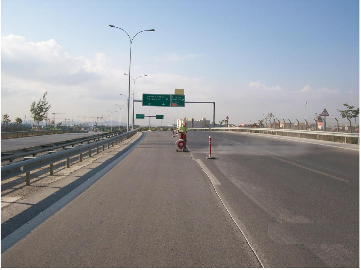
Şekil 6.7 : Kanal Açma Uygulaması
