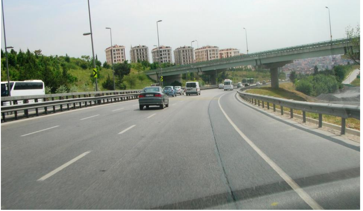
Şekil 5.6 : Kenar çatlak görüntüsü 2
