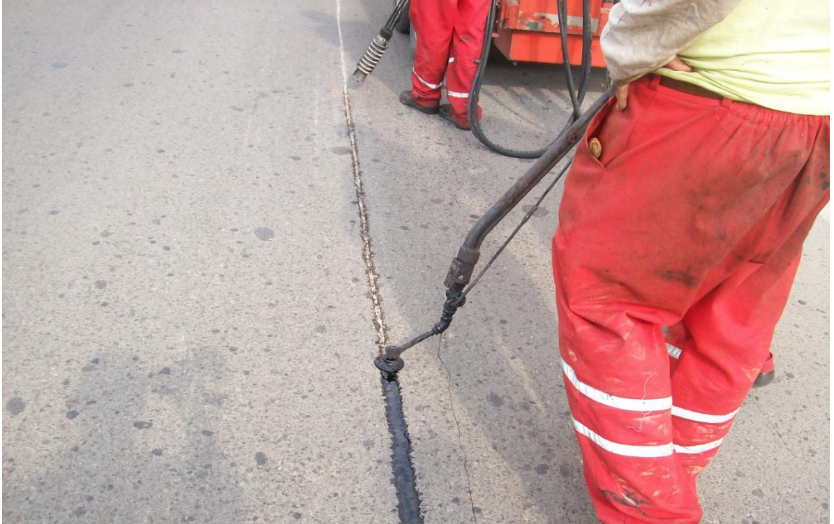
Şekil 6.8 : Derz/Çatlak Malzemesi Doldurma Uygulaması
