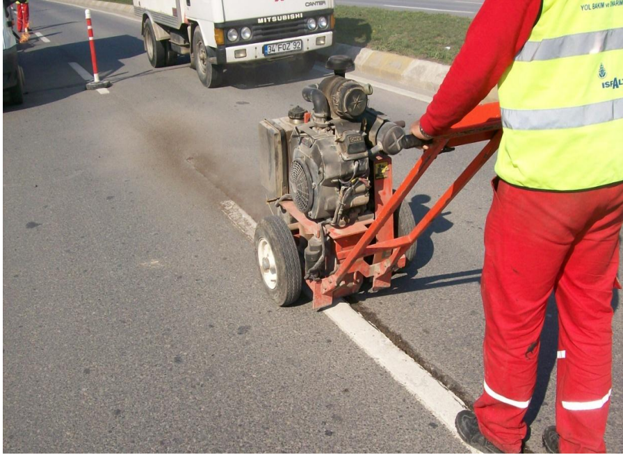
Şekil 6.4 : Kanal Açma Uygulaması Görüntüsü
