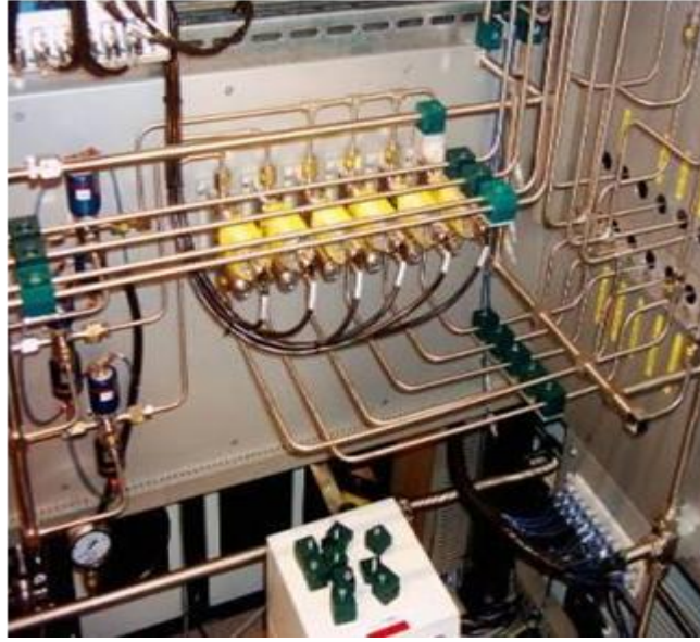
Şekil 3.8 Manifold sistemi. Gaz karışımı burada ayarlanarak reaktör odasına sevk edilir.
