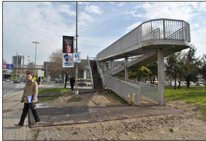
Şekil 5.27: Otobüs Durağı bağlantı rampası-Zeytinburnu
