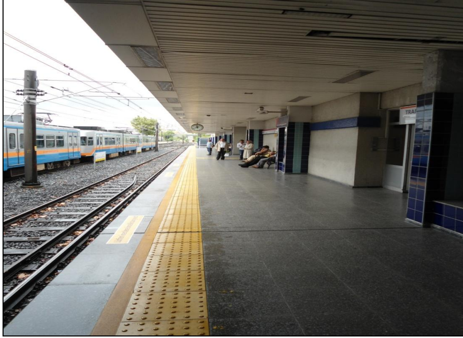
Şekil 5.45: Metro istasyonu yolcu platformu-Zeytinburnu
