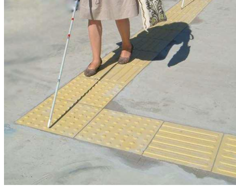
Şekil 10- Kılavuz iz ve yön değiştirme öğelerinin kullanımı (TSE, TS 12576, 2012)
