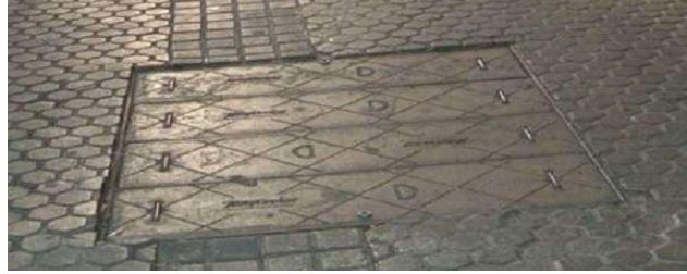
Şekil 7- Kaldırımda rögar kapağı örnek uygulaması (TSE, TS 12576, 2012)
