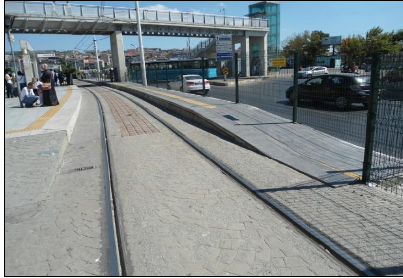
Şekil 5.26: Tramvay-metro istasyonu bağlantı rampası-Zeytinburnu
