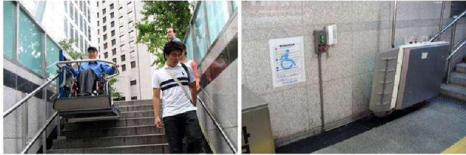
Şekil 34 - Yaya alt geçitlerinde merdiven eğiminde eğik asansör (TSE, TS 12576, 2012)
