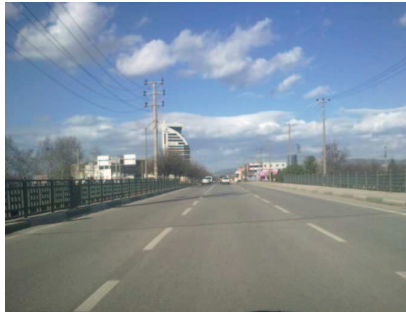
Şekil 4.68: Yeni Yalova Yolu Caddesi Nilüfer Deresi Köprüsü
