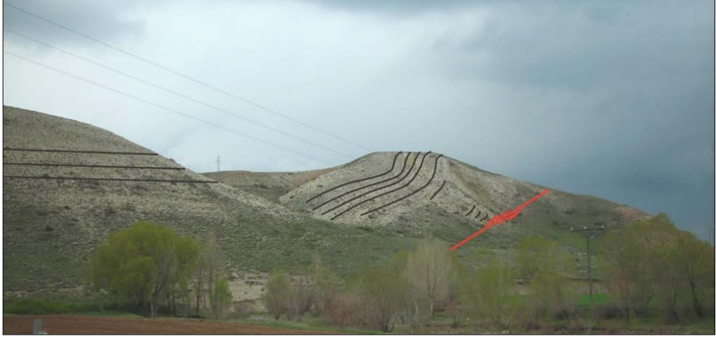
Şekil 3.12: Boz Tepe civarında yüzeyleyen Alt Miyosen yaşlı Deliktaş formasyonunu oluşturan kireçtaşı birimi ile çakıltaşı birimi arasındaki doğrultu atımlı sol yanal Başçayır Fayı'nın görünümü.
