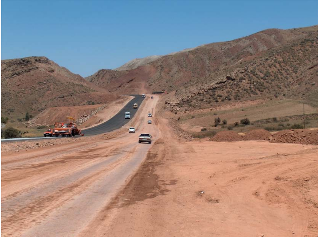
Şekil 4. Sivas güneyindeki Tecer ırmağı vadisinde yüzeyleyen Oligosen yaşlı Karayün formasyonunun kumtaşı, silttaşı ardalanmasından oluşan kesimlerinin genel görünümü (güneyden kuzeye bakış).
