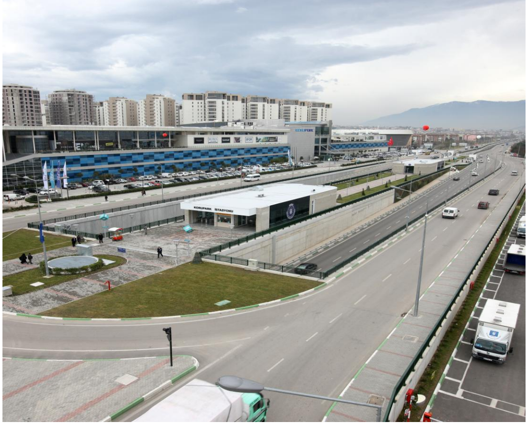
Şekil 3.4: BursaRay Emek Hattı tamamlanmış kısmı
