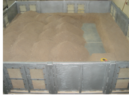
d. Üçüncü blok kazısı yapıldıktan sonra
