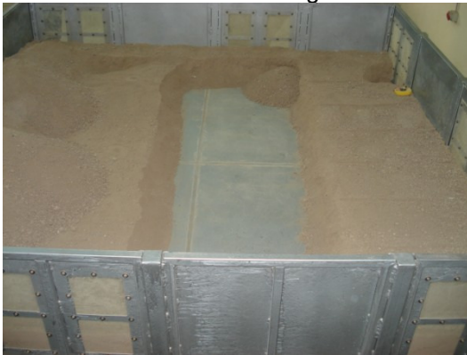
e. İkinci blok 1. Set kanal kazısından sonra
