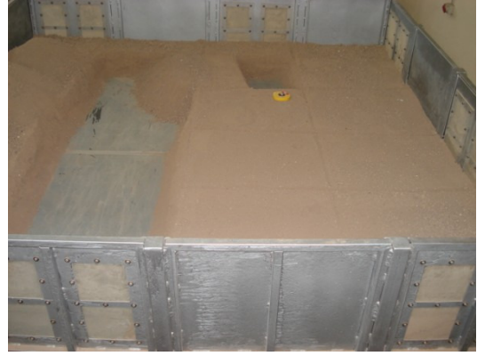
b. Birinci blok 1. Set kanal kazısından sonra
