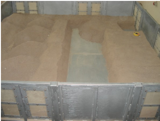
e. İkinci blok 1. Set kanal kazısından sonra
