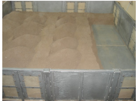
f. İkinci blok kazısından sonra
