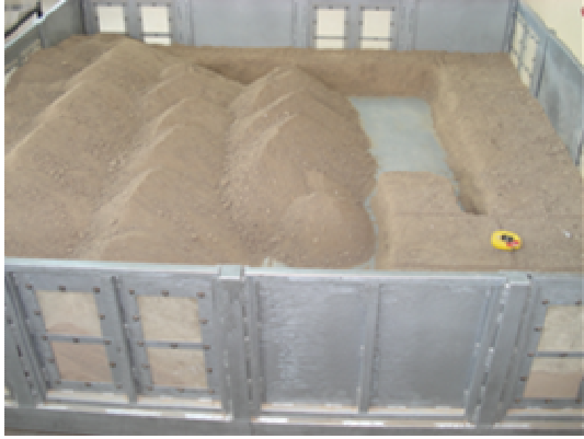
c. İkinci dilim kanal kazısı yapıldıktan sonra
