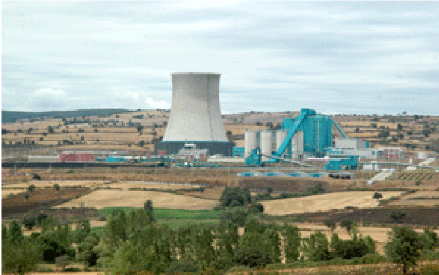
Şekil 3. 18 Mart Çan Termik Santrali genel görünüşü.
