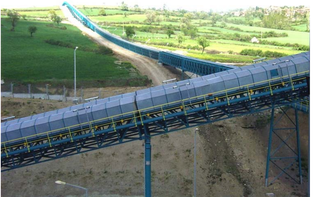
Şekil 8. 18 Mart Çan Termik Santrali kül taşıma bantları.
