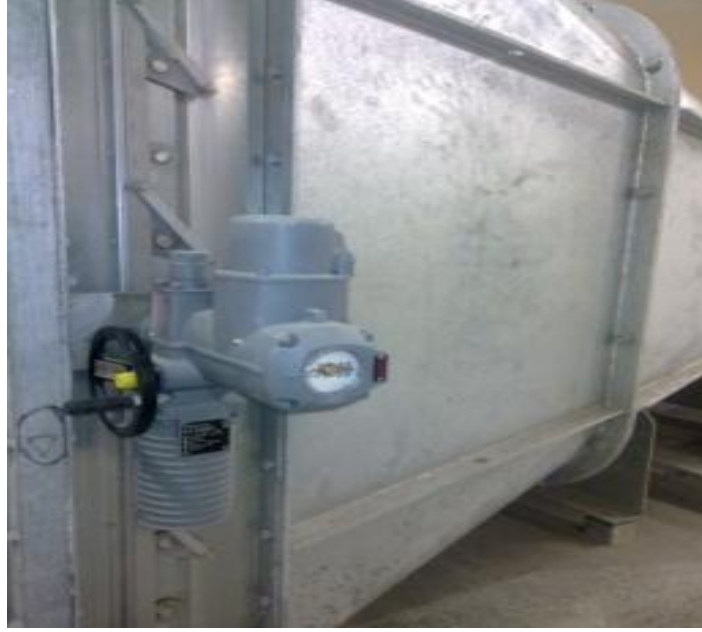
Şekil 5. 27: Elektrik motorlu damper
