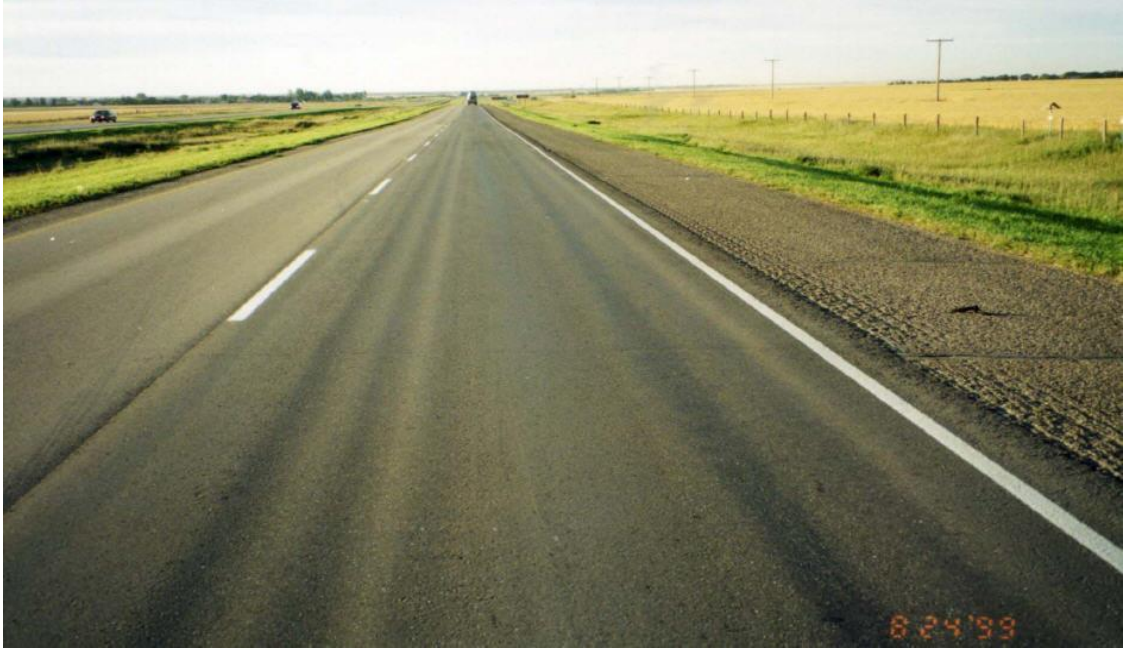
Şekil 4.8 : Tekerlek izinde oturma
