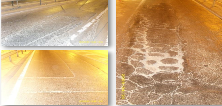
Şekil 5.7 : Yüzey deformasyonları
