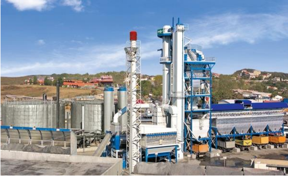
Şekil 3.1 : Batch-Mix tipi asfalt plenti 1
