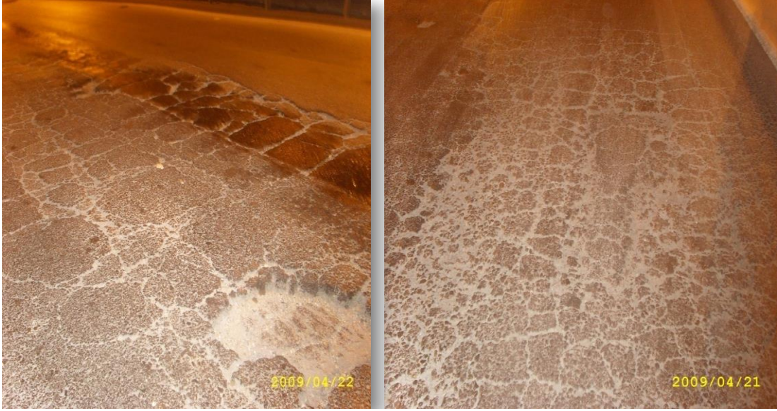
Şekil 5.3 : Yorulma çatlak
