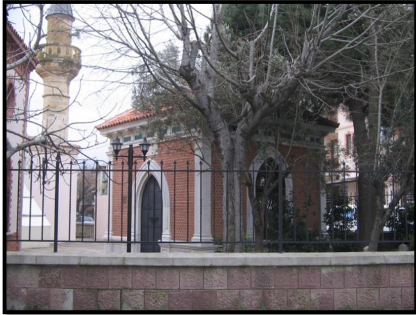
Şekil 4.53. Kayserili Ahmet Paşa Camii (Özgün, 2010).
