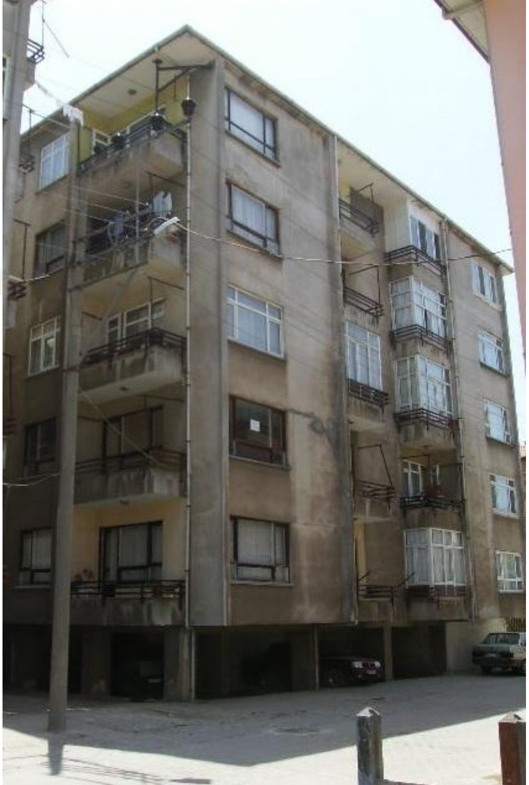
Şekil 5. 4. Bölgedeki yapısal durumu kötü binalara örnek
