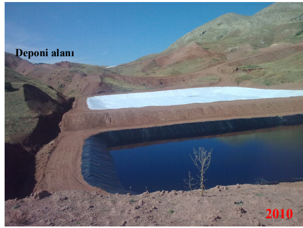
Resim 5.1. Düzensiz deponi alanının G'inde yapımı süren havuz inşaatları alanı.
