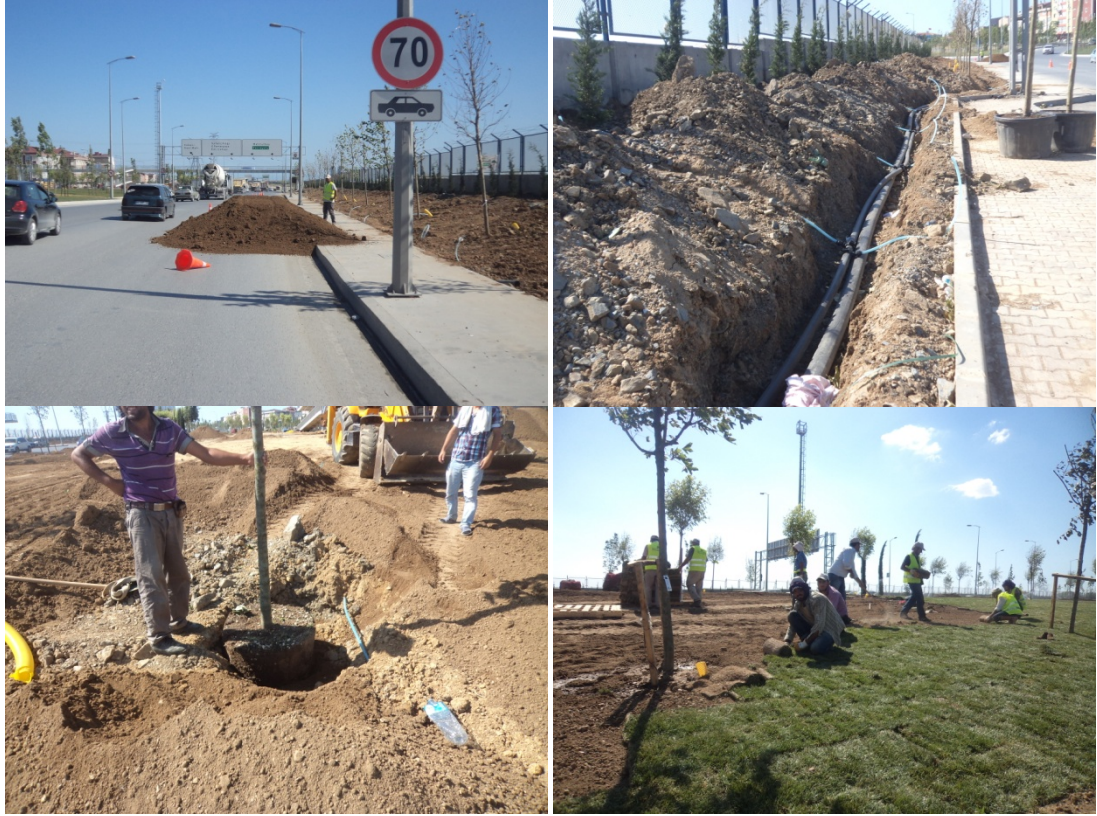
Şekil 5.12 Toprak serimi, Sulama Tesisatı, Ağaç dikimi ve Hazır rulo çim serimi (Kadı, 2013)
